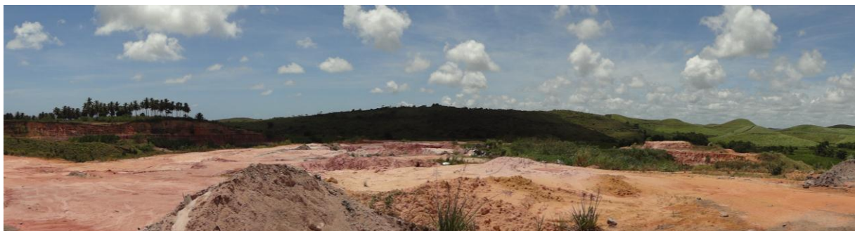
Figura 35. Área exposta à erosão, devido a extração de material para construção.
