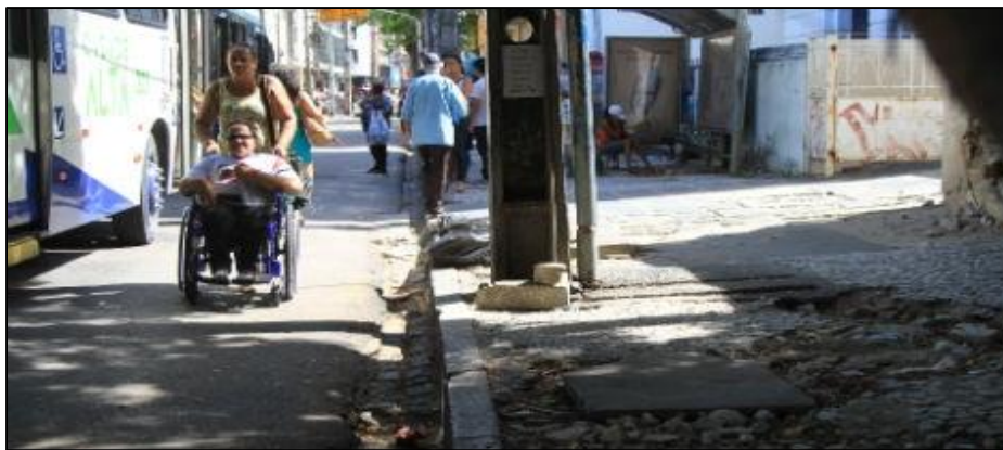
Figura 15: Calçada na Rua do Hospício no Recife
