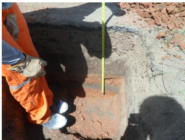
Figura 13 - Poço realizado na PE-50 em 2015
