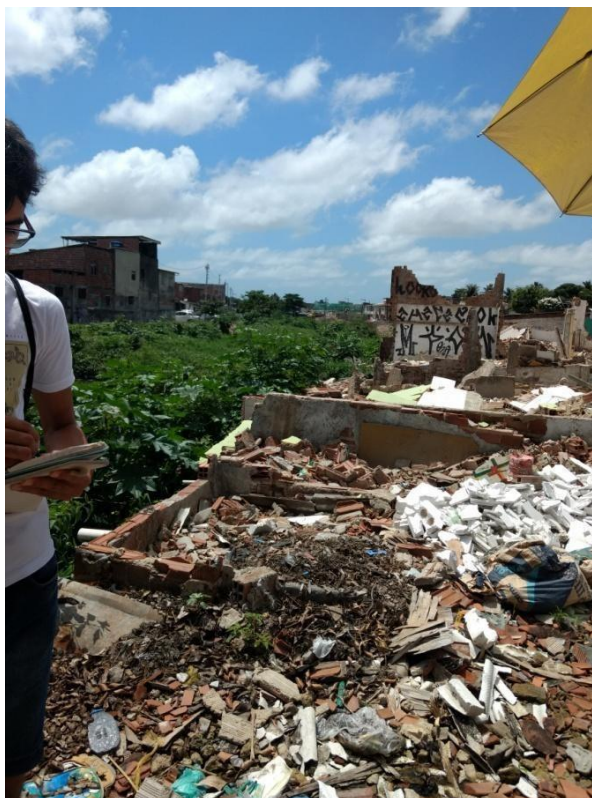
Figura 56- Marca das casas removidas no leito do rio, pelo PAC-Beberibe
