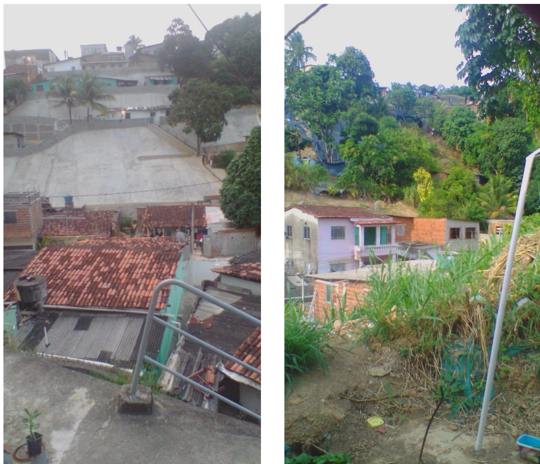
Figura 12- Obra da prefeitura com muros de arrimo contra o deslizamento de barreiras
