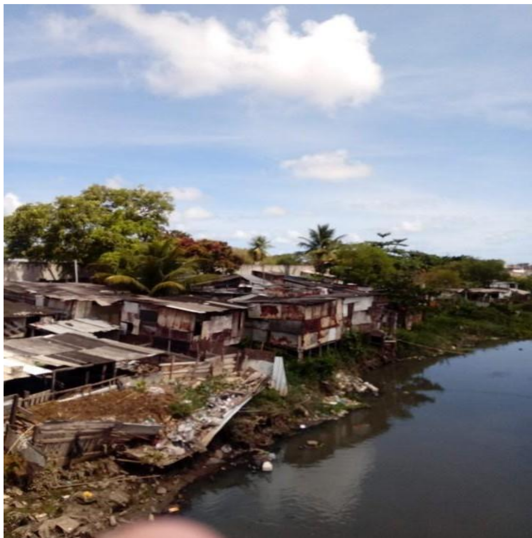
Figura 38- Vista da ponte entre Peixinhos e Campina do Barreto, para as palafitas na beira do rio Beberibe, onde se localiza o lar do entrevistado Flávio Roberto.
