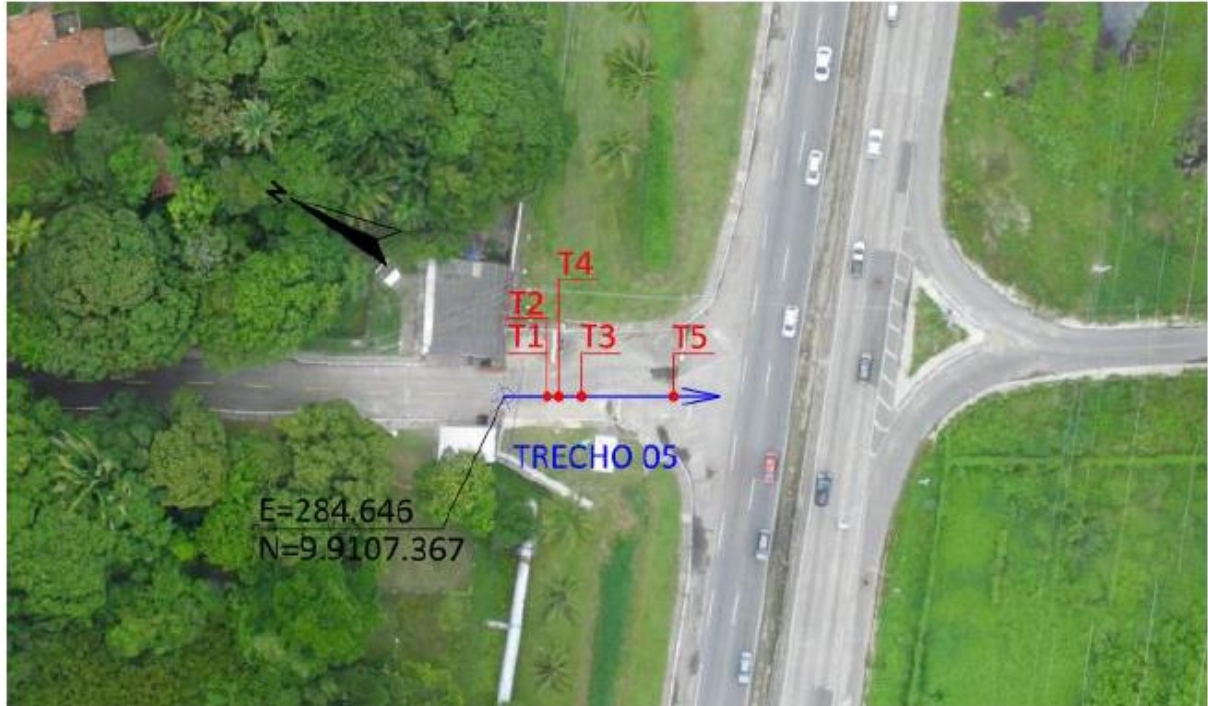
Figura 31 – Trecho 05 do levantamento por GPR
