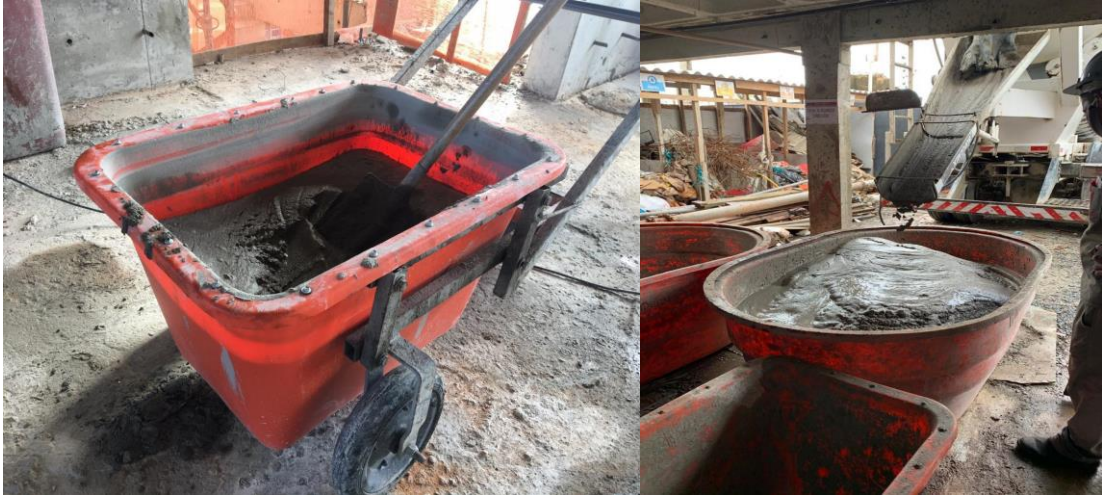
Figura 25 – Armazenamento, recebimento e transporte de argamassa estabilizada
