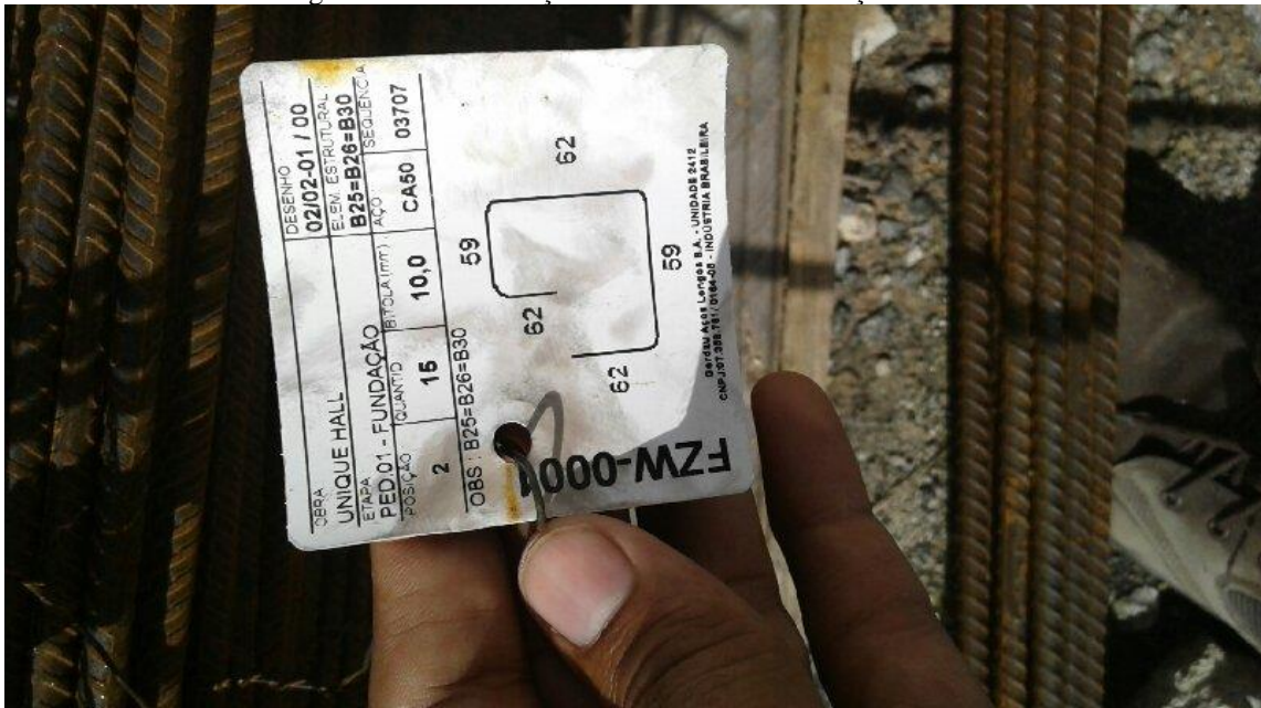
Figura 35 – Identificação e armazenamento do aço em obra
