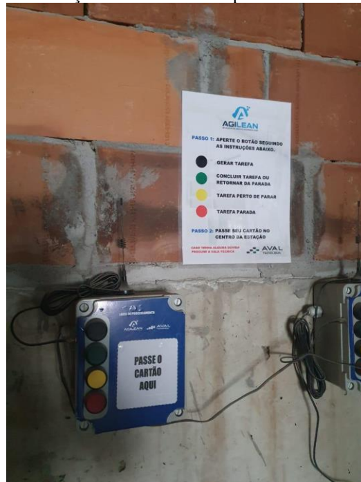
Figura 46 – Estação instalada com chips conectados ao servidor
