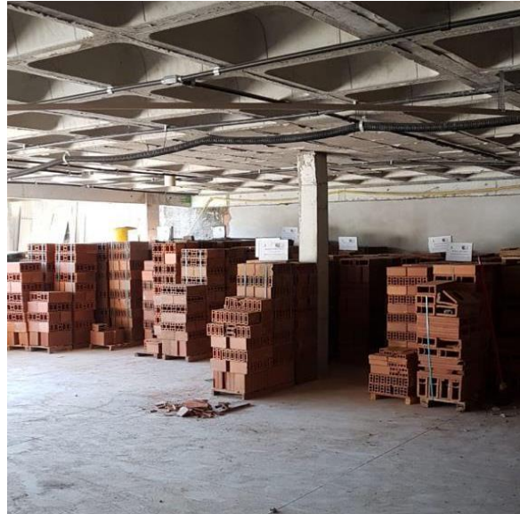
Figura 32 – Pátio de armazenamento de blocos cerâmicos em pallets
