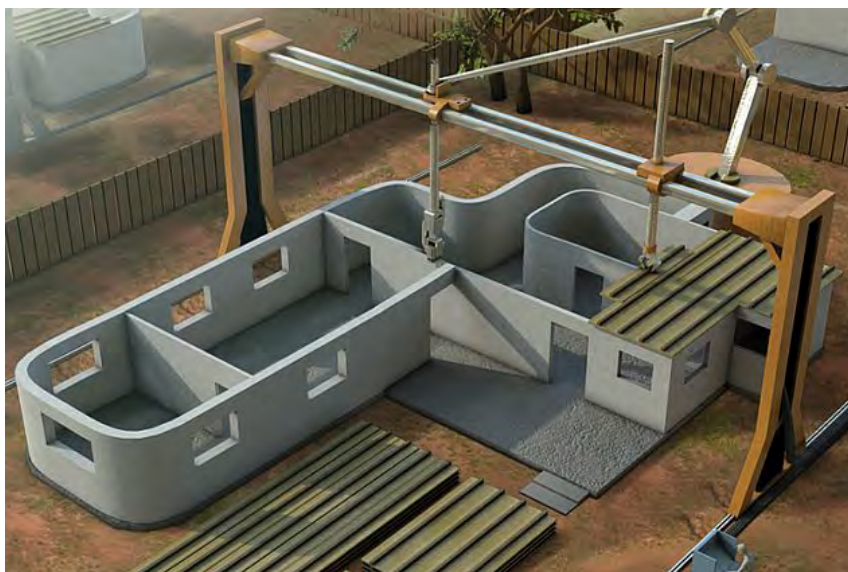
Figura 11 - Uso de impressora 3D para construção de casas.
