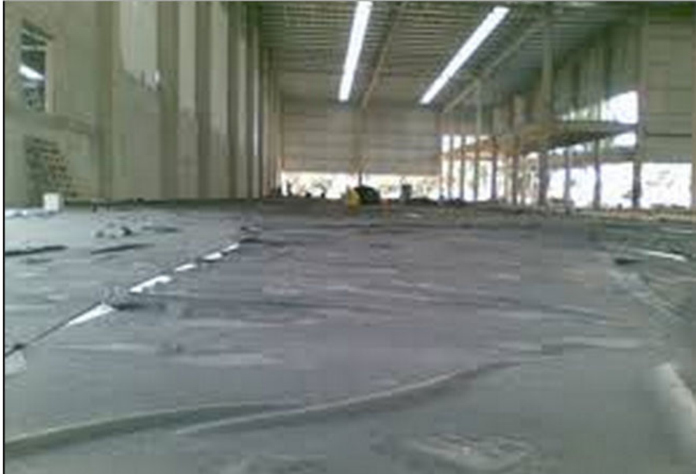
Figura 36: Cura úmida com manta geotêxtil.
