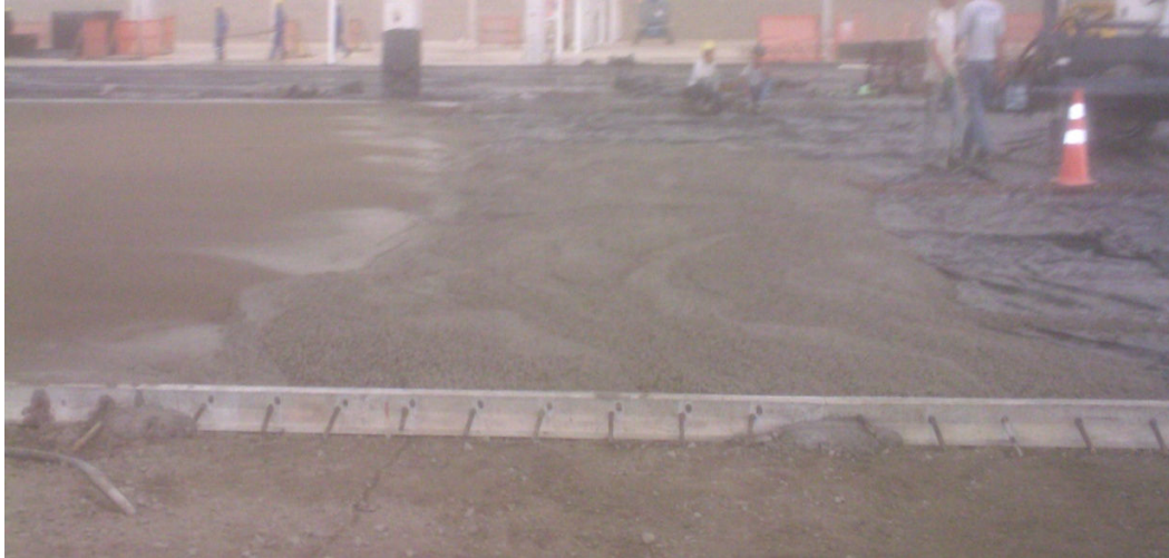
Figura 22: Fixação de fôrmas com concreto, devendo ser realizado com um dia de antecedência para o concreto curar.
