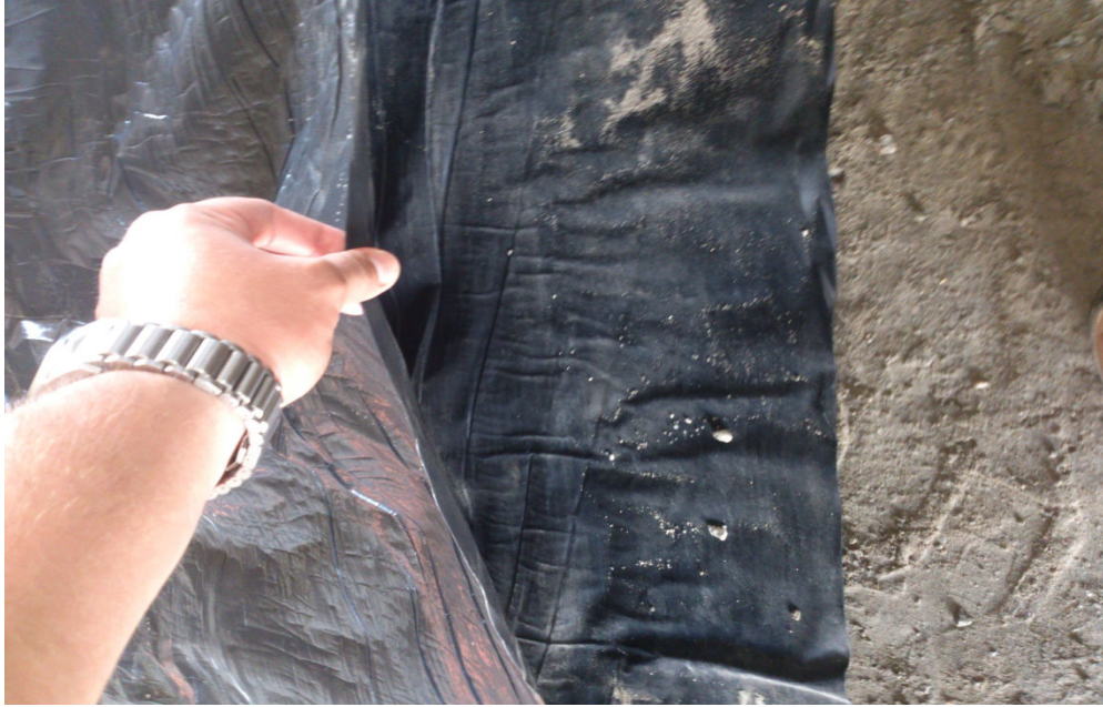
Figura 20: Detalhe mostrando que foi colocada lona dupla.
