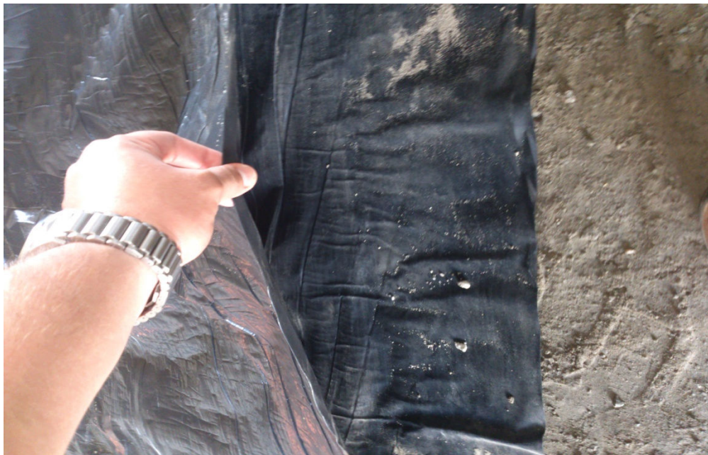
Figura 4: Detalhe da camada de vapor.
