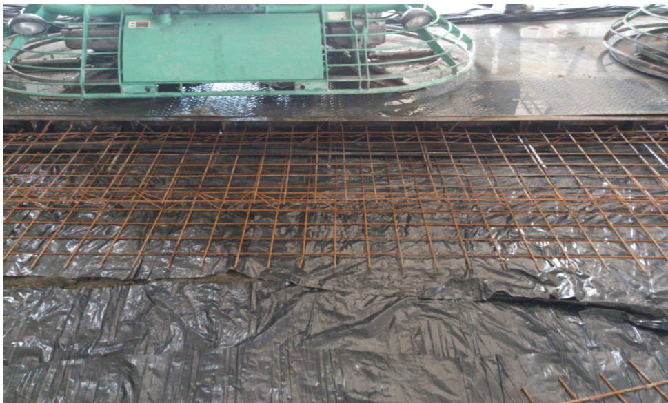
Figura 26: Exemplo de armadura dupla, com tela eletrossoldada, e espaçadores soldados.
