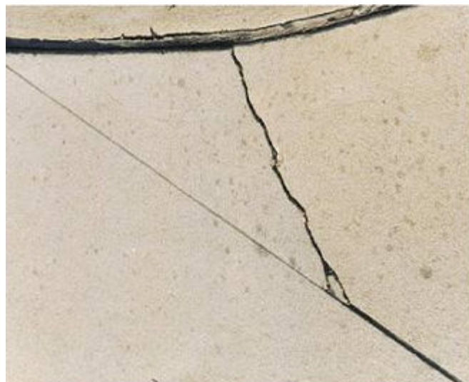
Figura 48: Encontro de junta serrada e junta de construção, gerando fissura.
