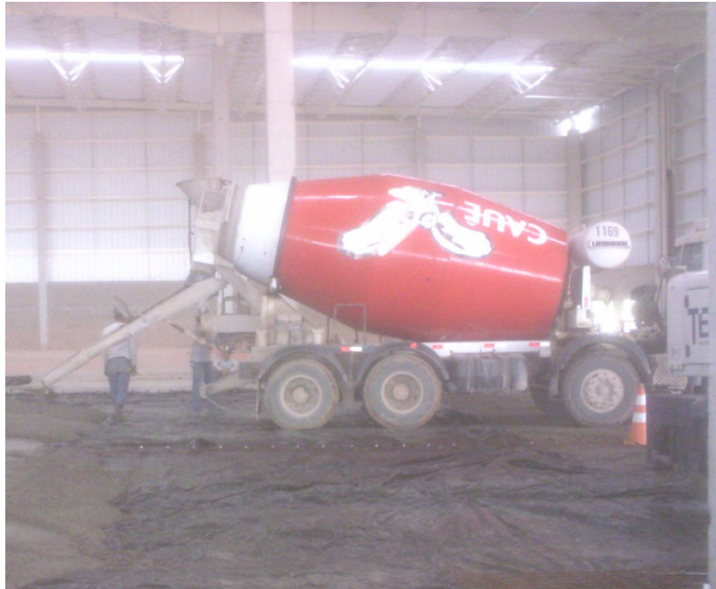
(A) Figura 7: Caminhão betoniera com três bicas e capacidade de 8m 3 .
