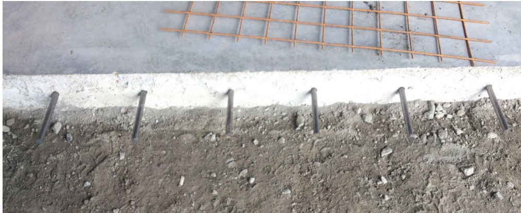
Figura 29: Posicionamento de barras de transferência, região das juntas de concretagem para dar trabalhabilidade a uma placa em relação a outra, um lado fica engraxado e o outro fica fixo. O espaçamento entre elas é marcado na própria fôrma.
