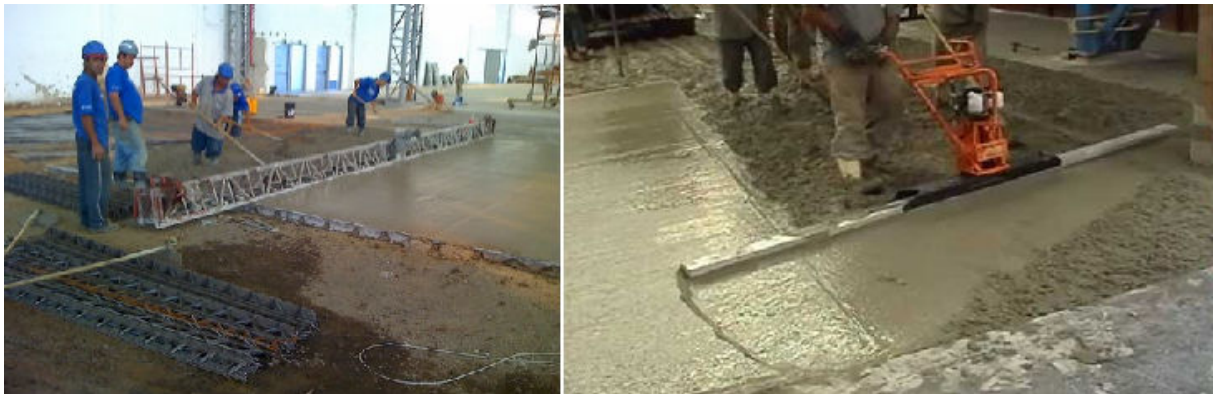
(A) Figura 10: A esquerda régua vibratória treliçada, a direita régua vibratório não treliçada.
