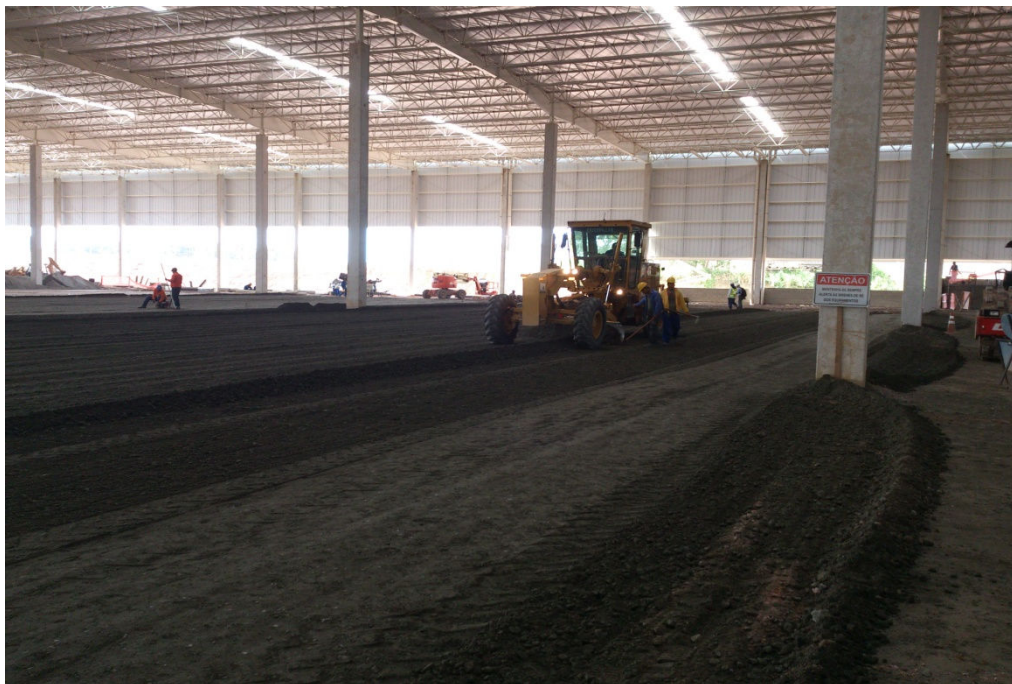
Figura 15: Moto niveladora espalhando e nivelando material (BGS).
