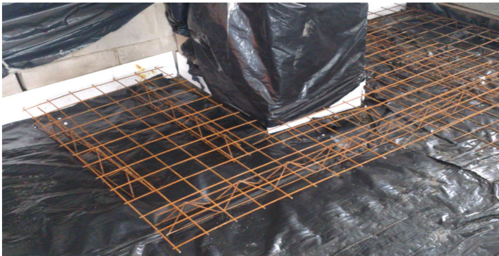
Figura 25: Amadura dupla de contorno de pilar, com tela eletrossoldada.
