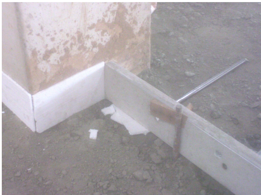
Figura 21: Fixação de fôrmas com ponteiros de aço.
