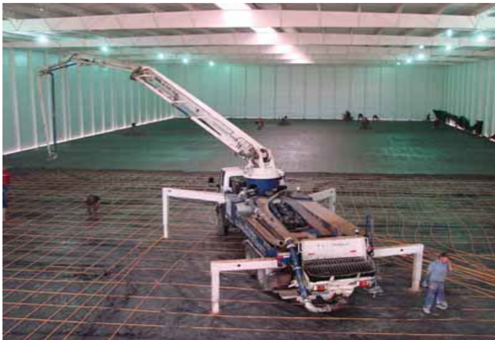
Figura 31: Lançamento de concreto com bomba lança.
