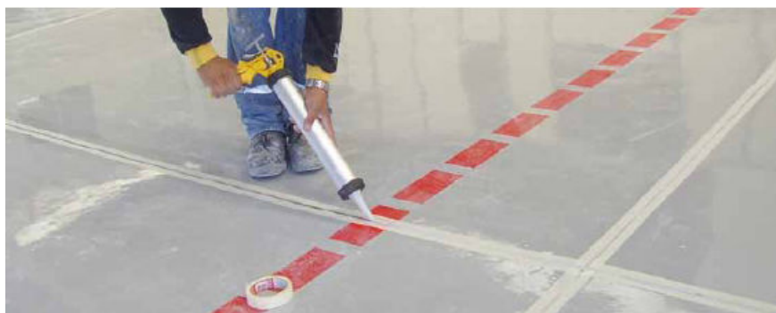
Figura 41: Aplicação de Selante monocomponente para selagem de juntas.
