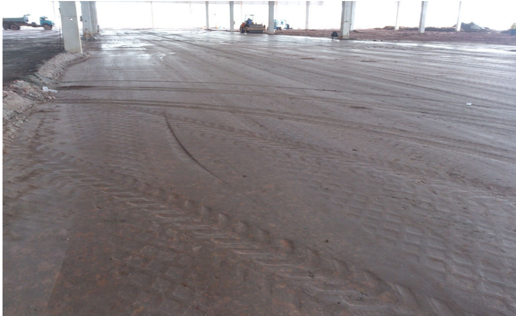
Figura 13: Subleito concluído, logo após compactação com rolo liso.
