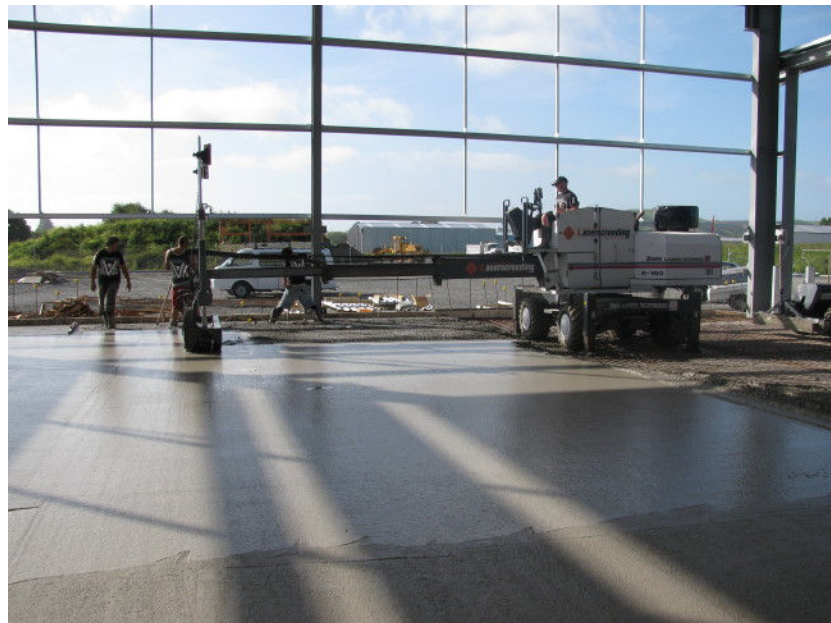
(A) Figura 8: Laser Screed em operação.
