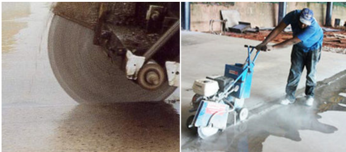
(A) Figura 11: Máquina policorte executando uma junta serrada.
