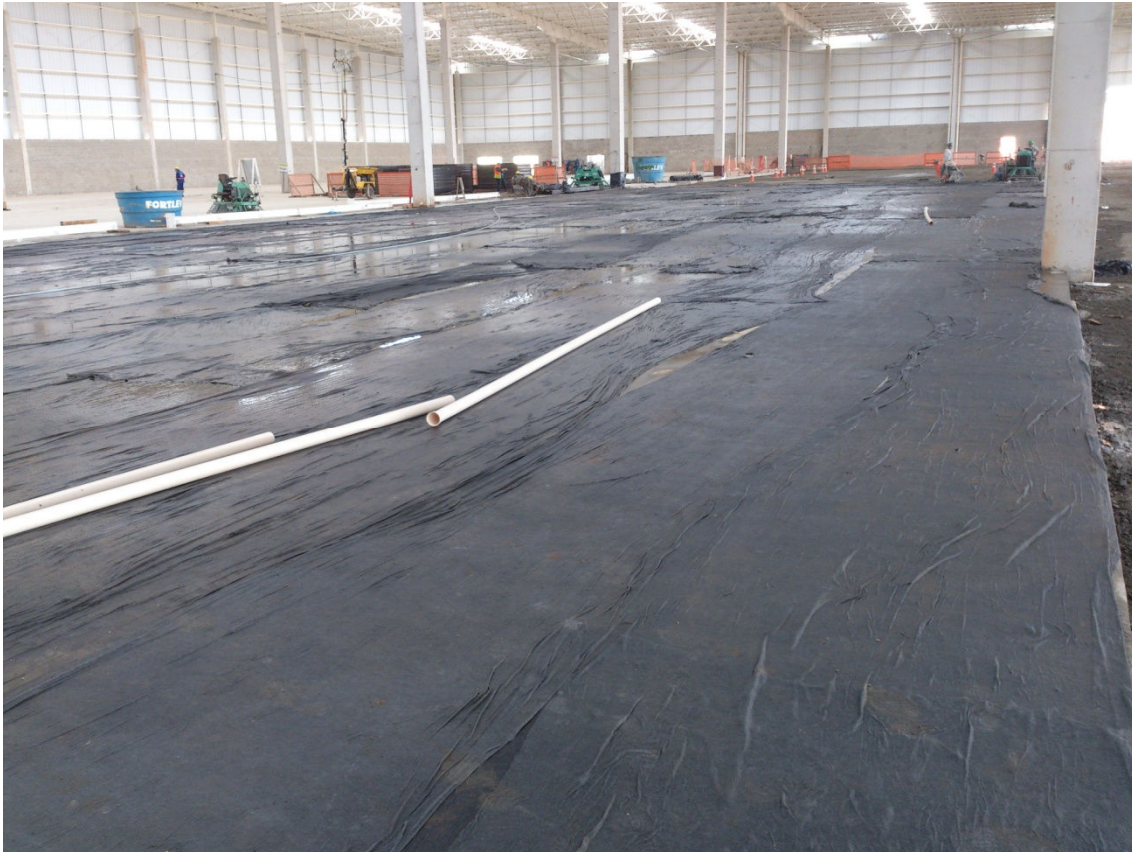
Figura 8: Cura úmida do piso, com manta geotêxtil.
