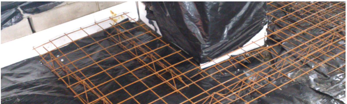
Figura 39: Uso de EPS onde para preparação de juntas de isolamento.
