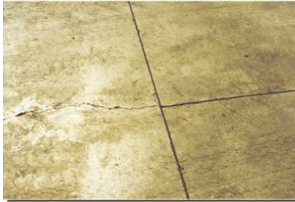
Figura 47: Junta de construção terminando em um junta serrada, gerando uma trinca.
