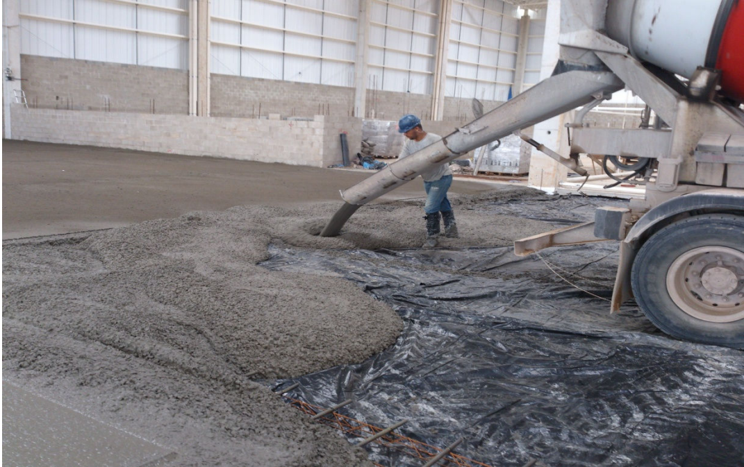
Figura 30: Lançamento de concreto realizado diretamente do caminhão, com a utilização da terceira calha (bica).
