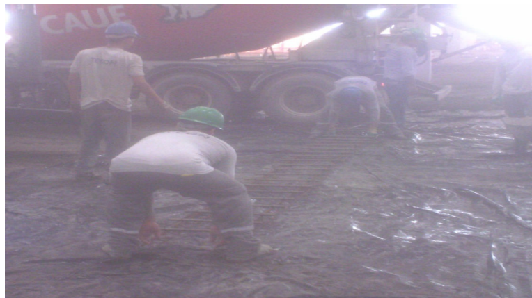
Figura 24: Equipe de execução de piso realizando posicionamento da armadura de depois que seu posicionamento foi locado topograficamente.
