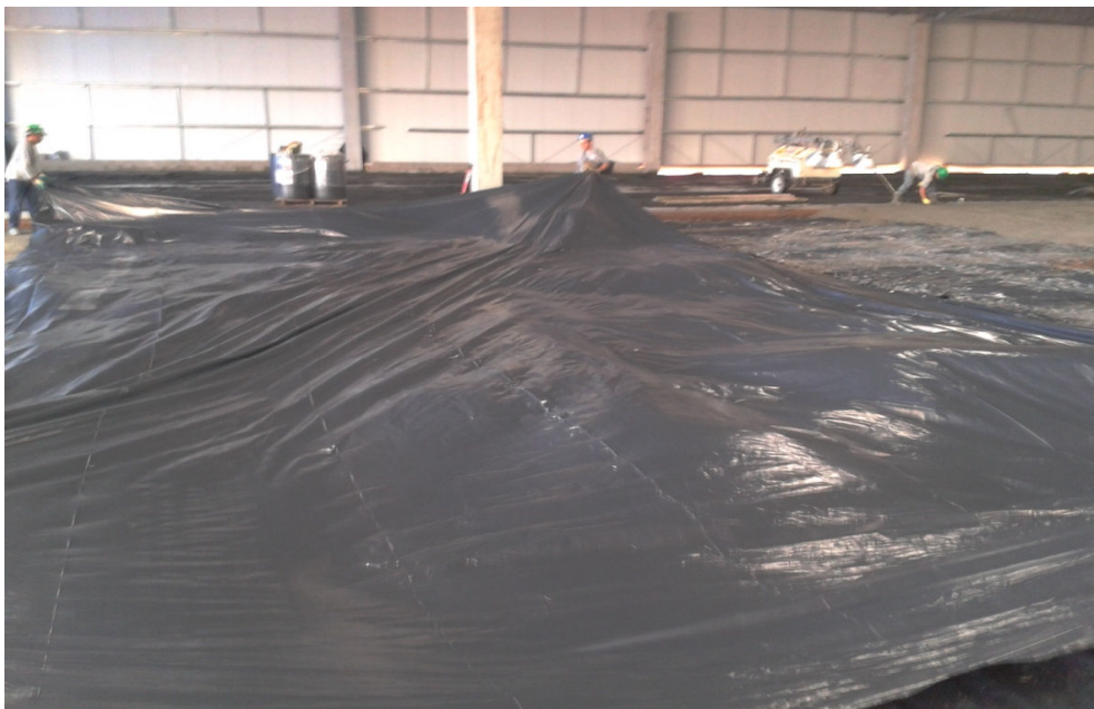
Figura 19: Posicionamento da camada de vapor, realizada em toda a área que será concretada.
