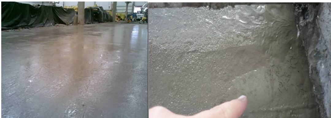
Figura 5: Aparência da superfície do concreto quando ocorre exsudação.
