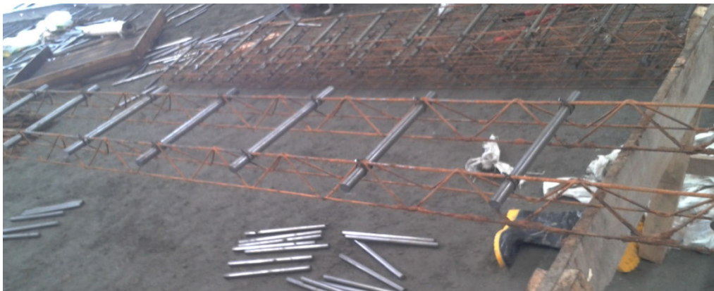
Figura 28: Posicionamento das barras de transferência, regiões onde serão realizados juntas serradas.
