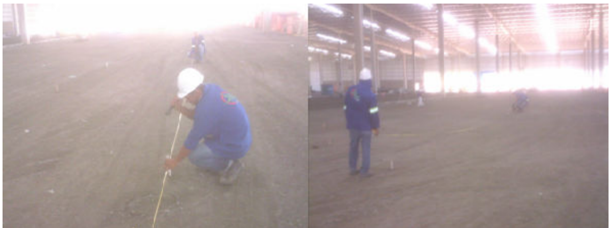
Figura 16: Levantamento altimétrico da sub-base.
