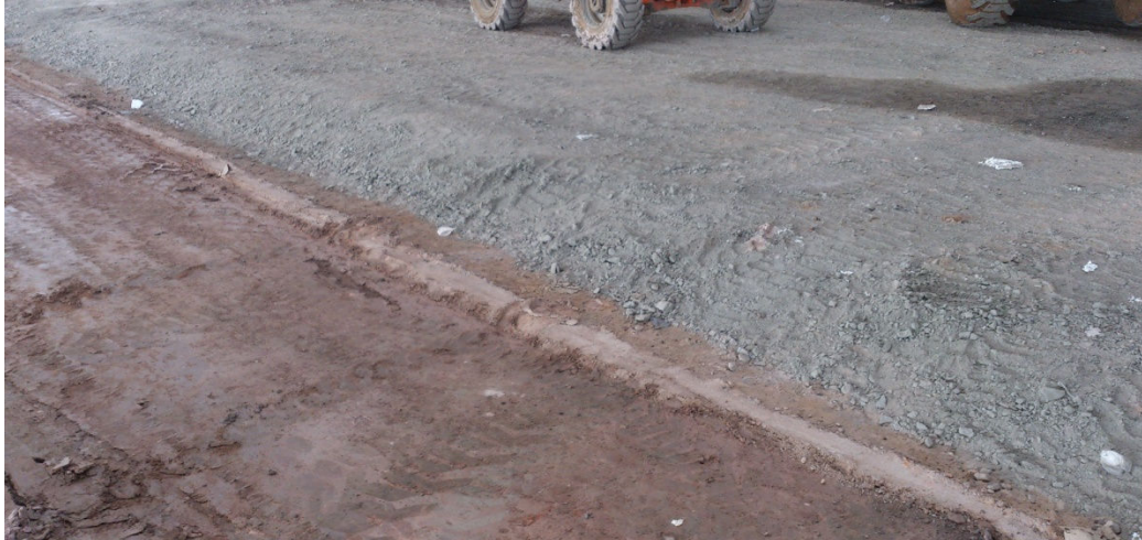
Figura 3: Detalhe do subleito juntamente com a sub-base.
