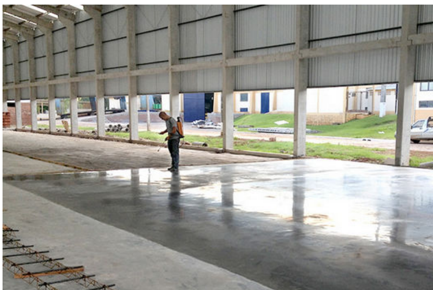
Figura 37: cura química sendo executada manualmente.
