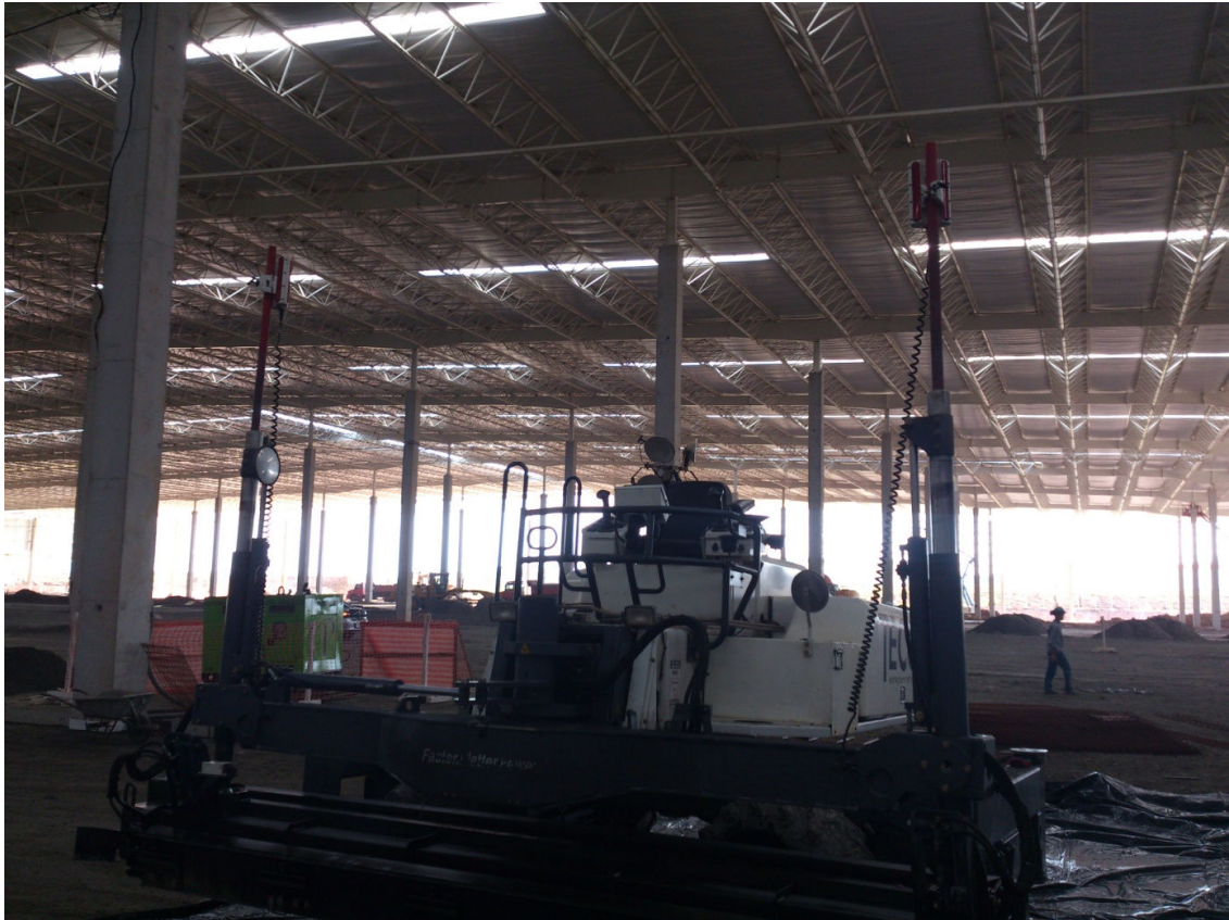
Figura 34: Detalhes das duas antenas receptoras de laser da Laser Screed.
