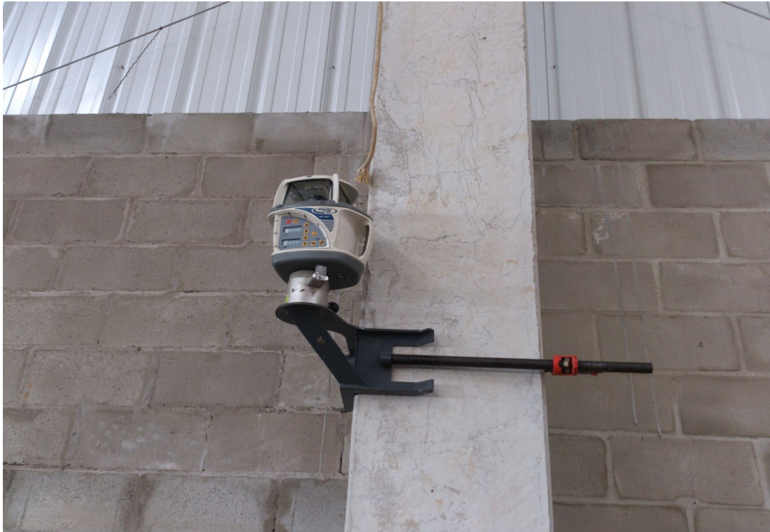
Figura 33: Aparelho que envia o sinal, com a função de nivelar piso.
