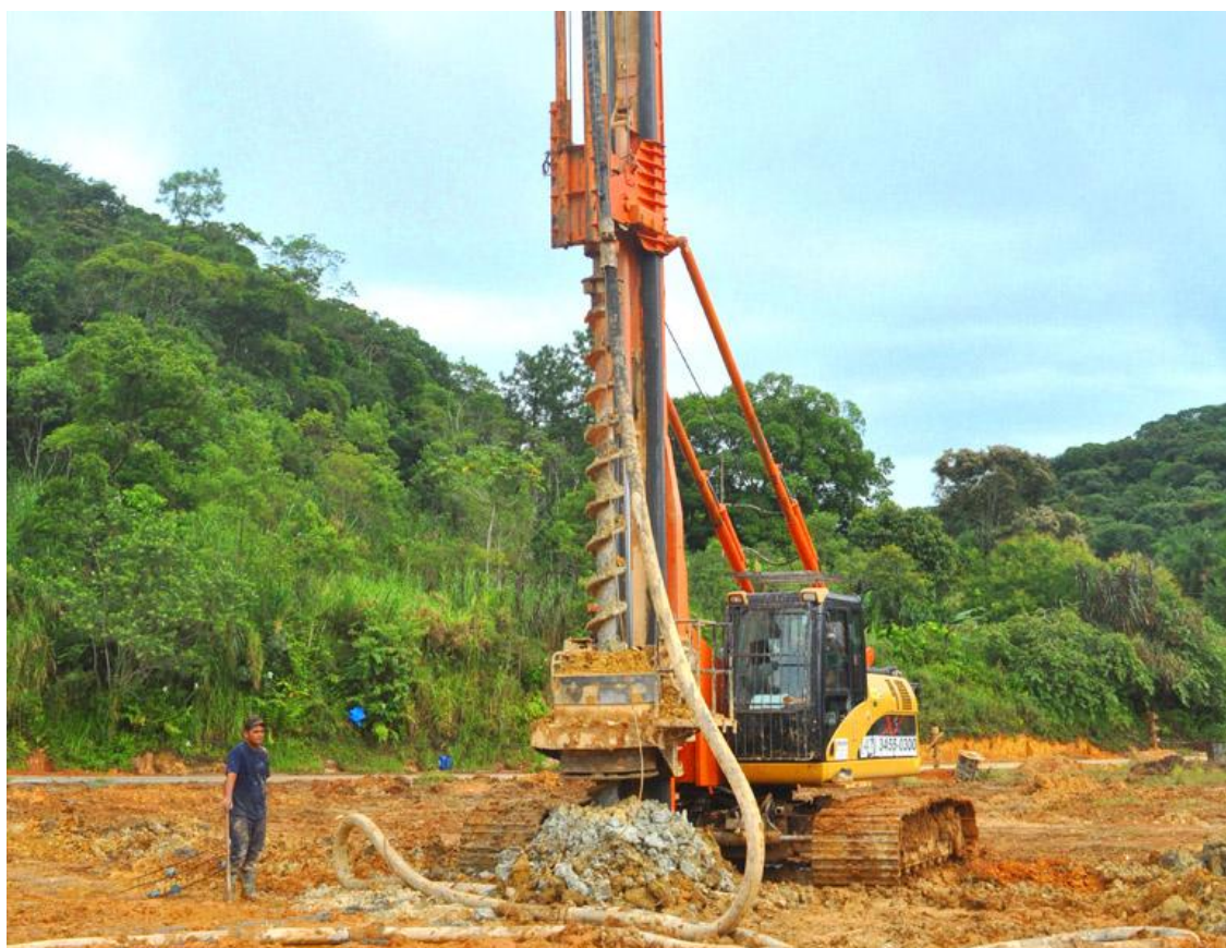
Figura 2.4 – Procedimento de concretagem da estaca Hélice Contínua
