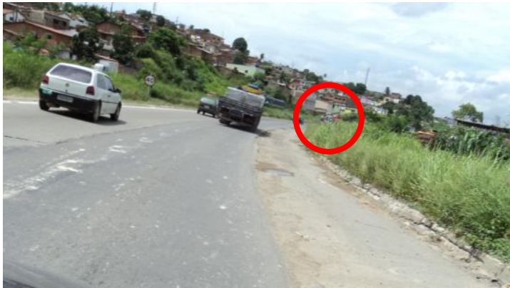
Figura 4: Sinalização Vertical encoberta pela vegetação. Fonte: Autores
