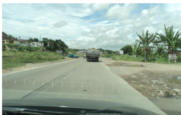
Figura 10: Sistema de drenagem ineficiente Fonte: Autores
