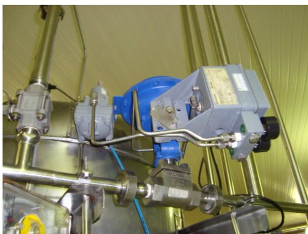
Figura 3.5 Válvula moduladora
