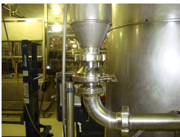
Figura 3.3 Válvula de retenção
