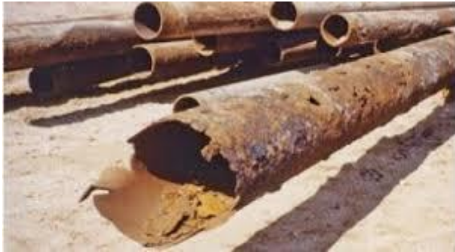
Figura 7 - Corrosão em tubos.
