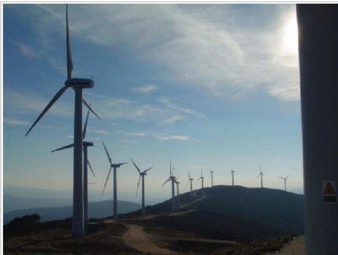
**Figura 3.11 - Exemplo de parque eólico com localização alinhada na perpendicular dos ventos dominantes**
