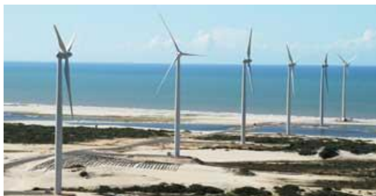
Figura 2.5. Parque Eólico Volta do Rio.
