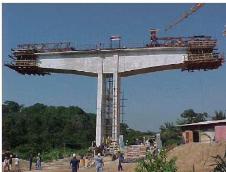
**Figura 2.8- Balanço sucessivo moldado no local (Fonte: Manual MIDAS)**
