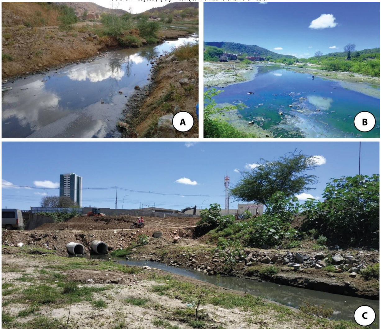
Figura 13 – (A) Local de amostragem; (B) Trecho do rio Capibaribe indicando processo de eutrofização; (C) Lançamento de efluentes.
