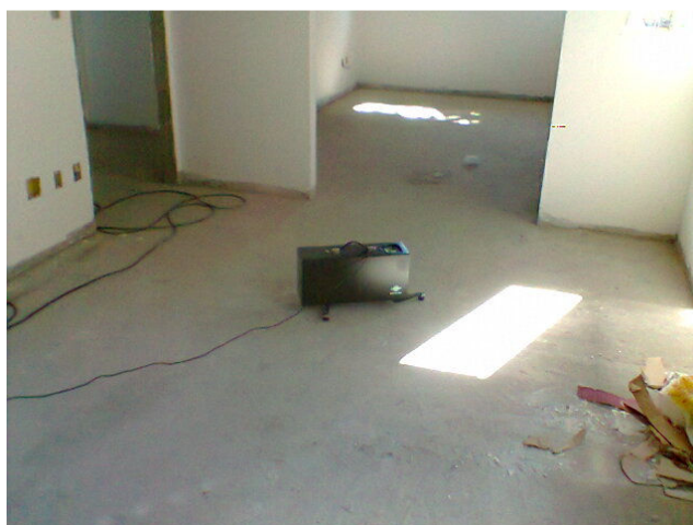
Foto 7 - Tapping Machine posicionada em piso da sala
