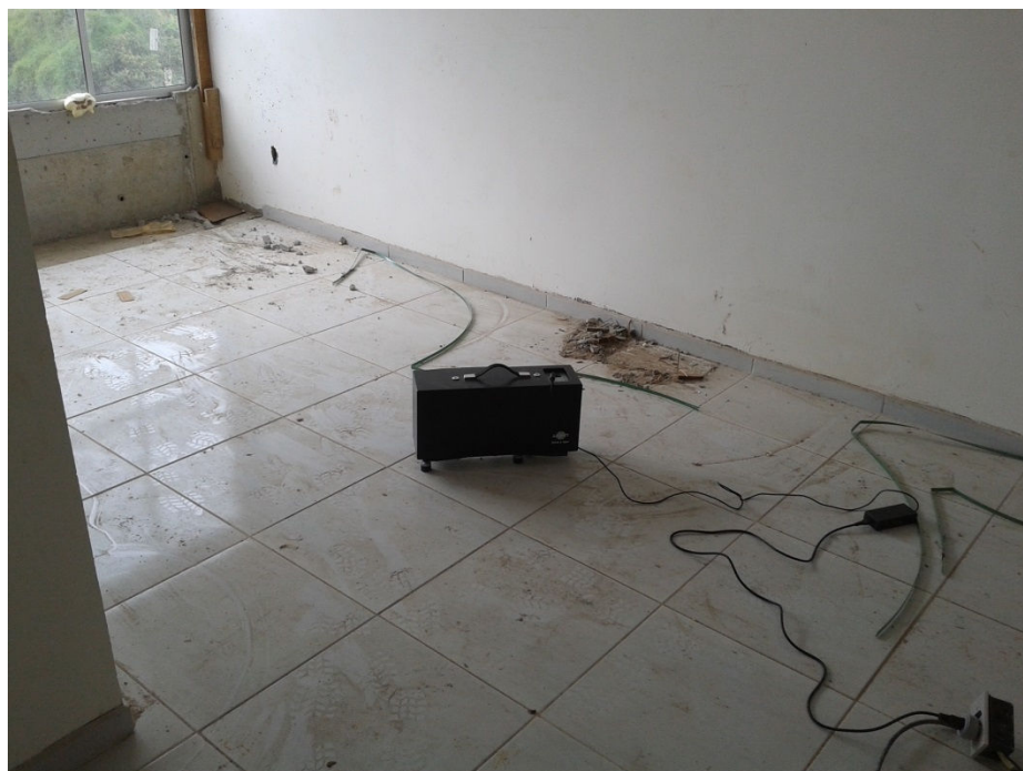
Foto 10 - Tapping machine utilizada em unidade com revestimento cerâmico.
