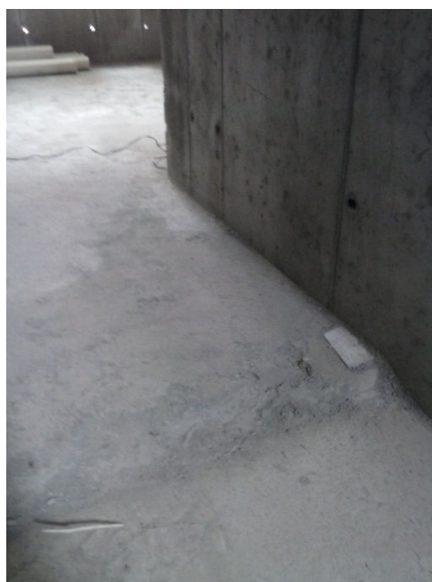
Foto 9 - Verificação da espessura do contrapiso (aproximadamente 5 cm)
