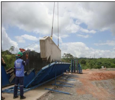
Imagem 9: Retirada da peça da fôrma
