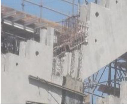
Imagem 1: Conexão entre vigas jacarés
