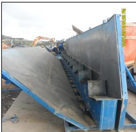
Imagem 4: Montagem das fôrmas metálicas
