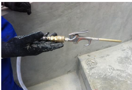
Figura 3.5 – Limpeza com Ar comprimido
