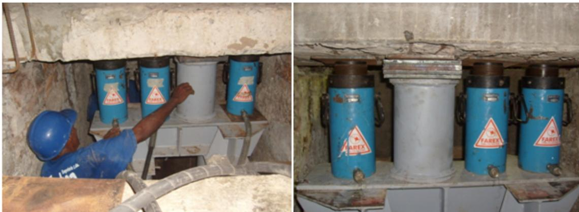
Foto 14 - Instalações dos macacos hidráulicos e reacionamento das estruturas
