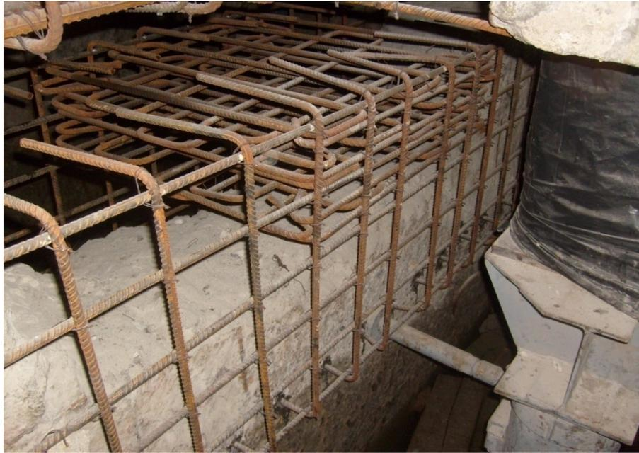
Foto 16 - Armadura de alargamento e fretagem
