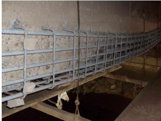
*Foto 19 - Armadura de reforço da longarina, protegida por pintura inibidora de corrosão, à base de zinco.*
