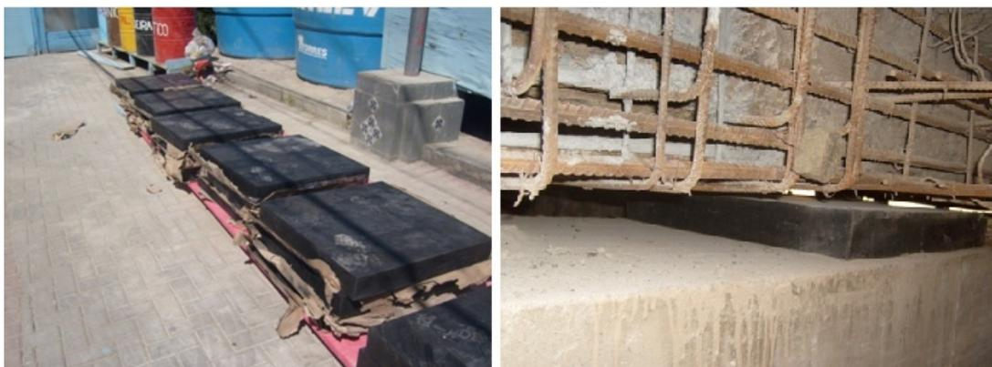
Foto 17 - Aparelhos em neoprene fretado/Aparelhos em neoprene instalados
