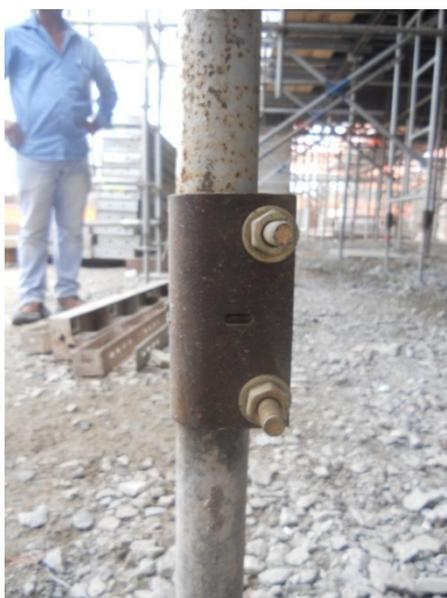
Figura 67 - Vista lateral da conexão por luva
