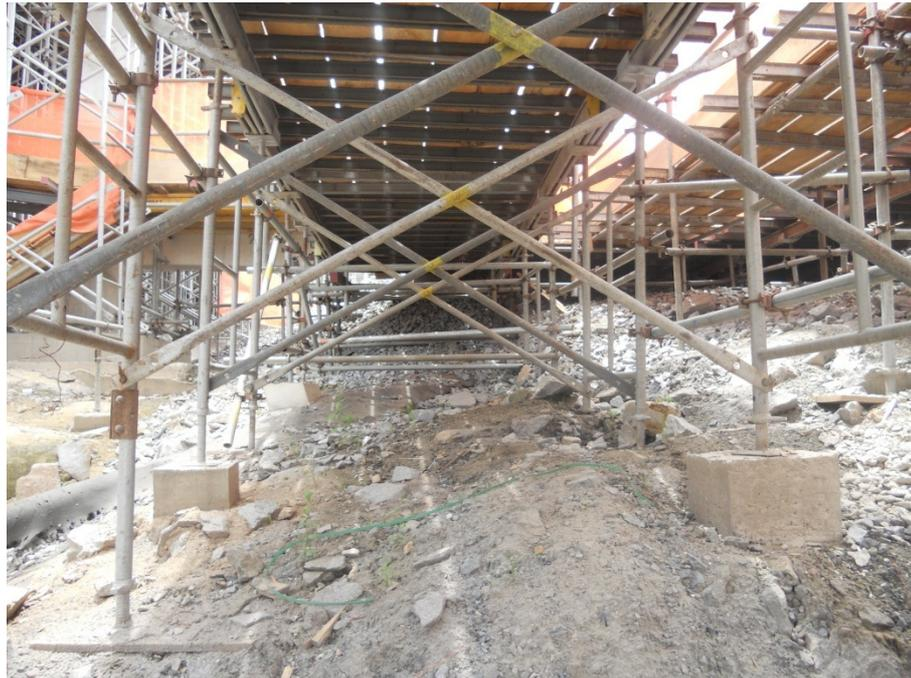
Figura 26 - Cruzetas conectadas a torres em terrenos desnivelados
