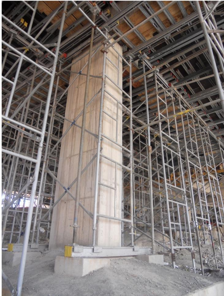
**Figura 16 - placas de base em terrenos desnivelados**
