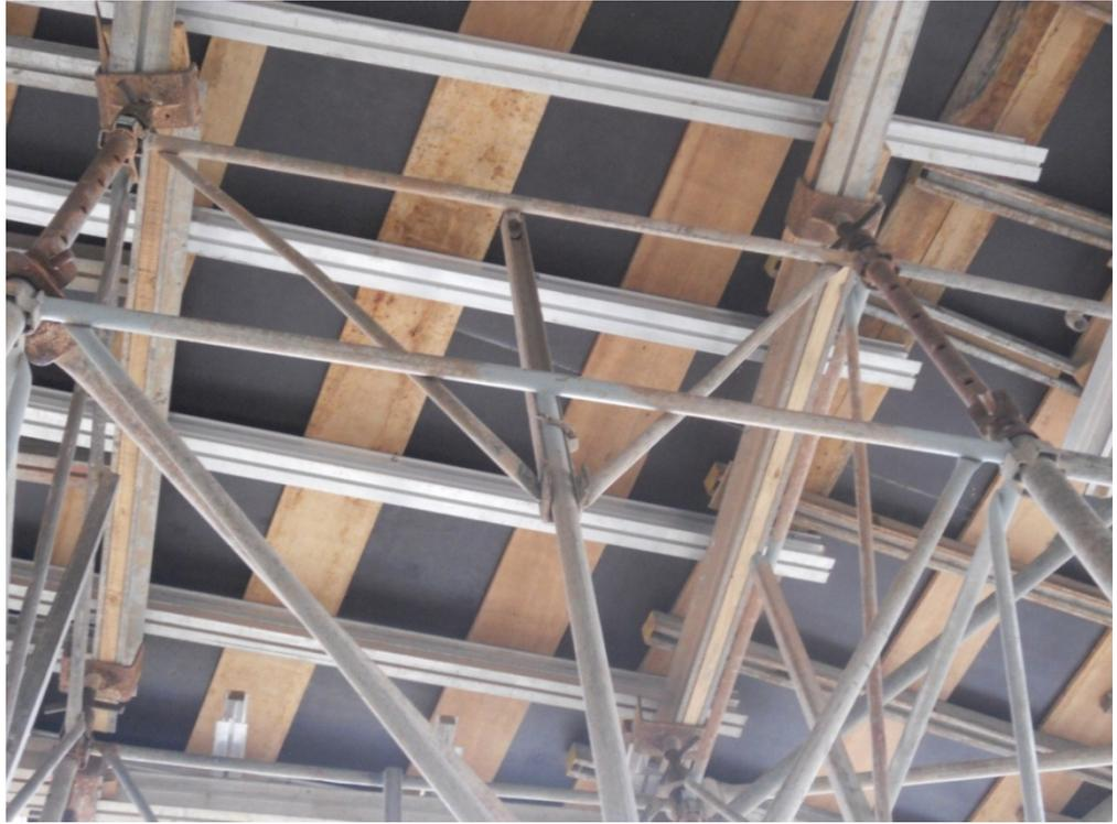
**Figura 42 – Conexão das flautas com os forçados**
