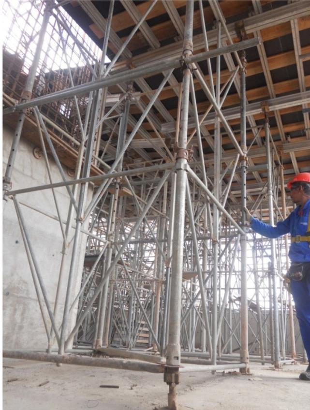
**Figura 44 - Conexão das flautas com os quadros**
