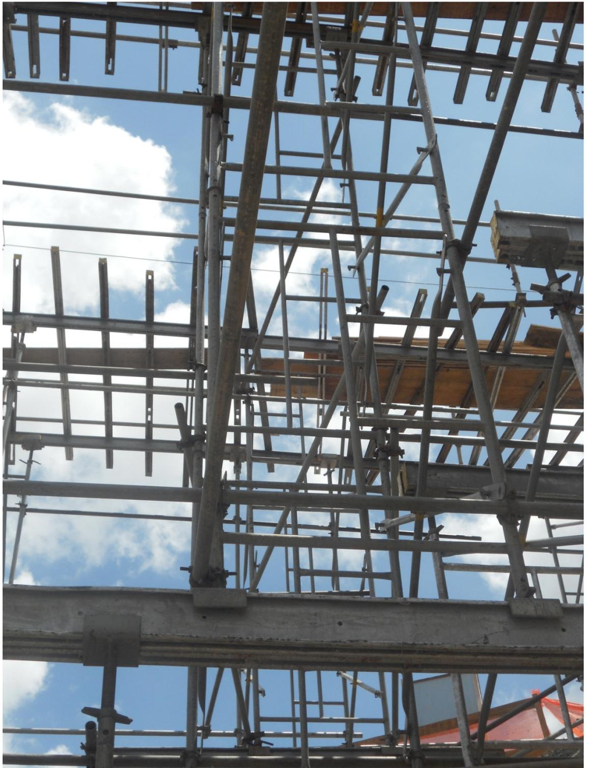
Figura 19 - Torres apoiadas em vigas
