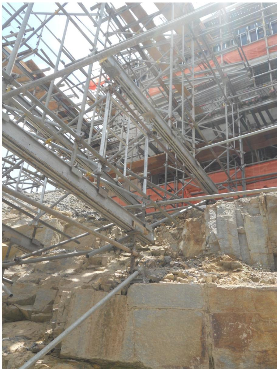
**Figura 18 - placas de base e vigas como base**
