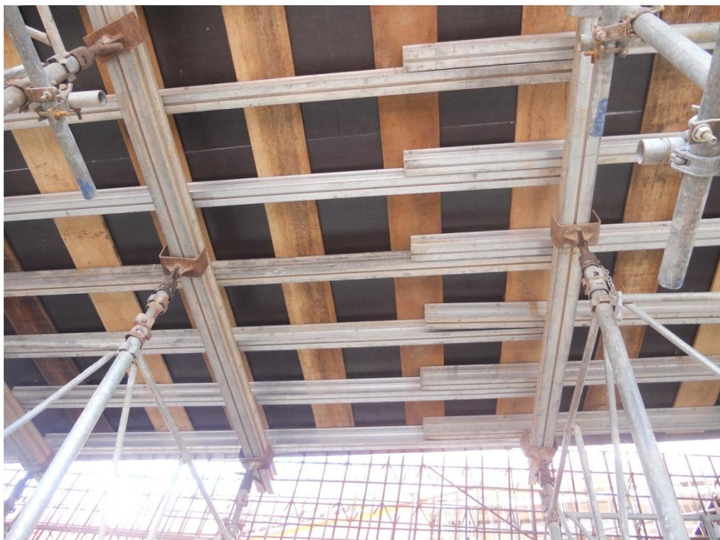
**Figura 34 - Montagem das vigas**
