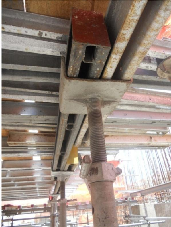
**Figura 13 - Conexão do forçado com as vigas**
