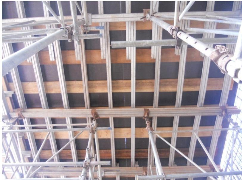
**Figura 45 - Outro angulo da conexão da flauta com os quadros**
