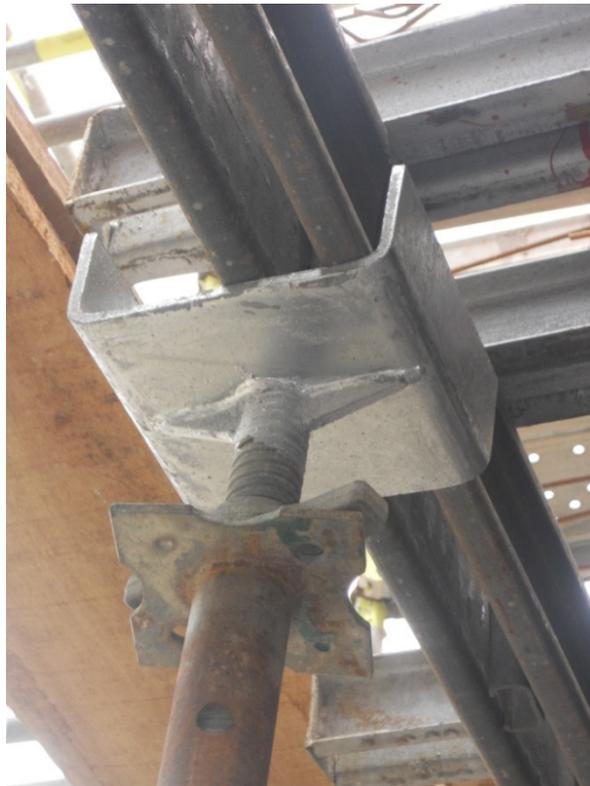
**Figura 14 - Conexão do forçado com a corneta**
