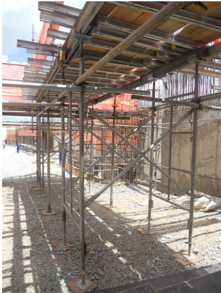
**Figura 25 – Posicionamento das cruzetas nas torres**
