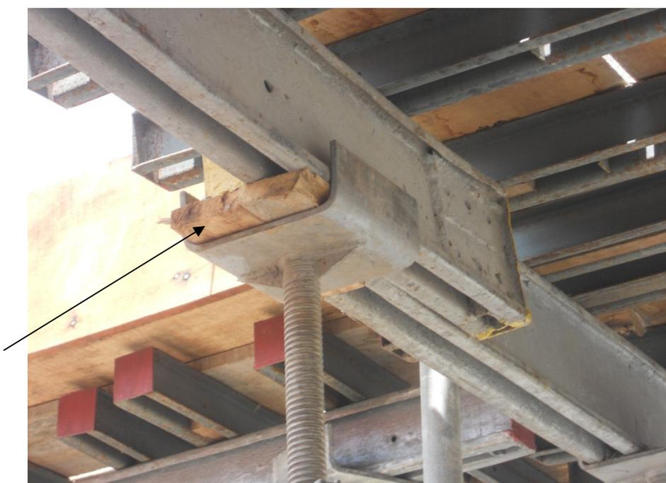
**Figura 29 - Erro de conexão, chapa de madeira entre o forçado e a viga**
