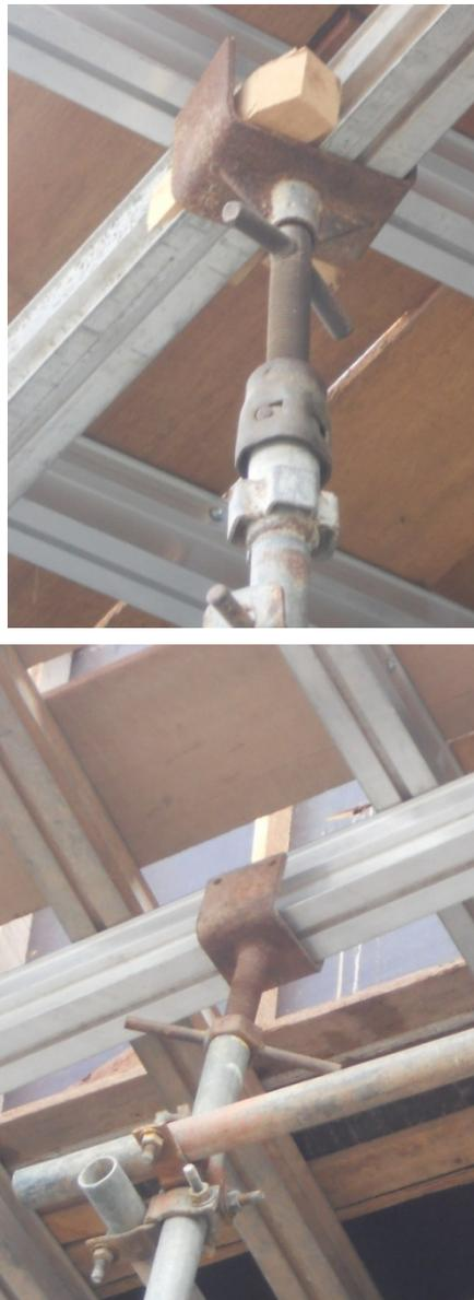
Figura 36 - Conexões dos forcados com as vigas
