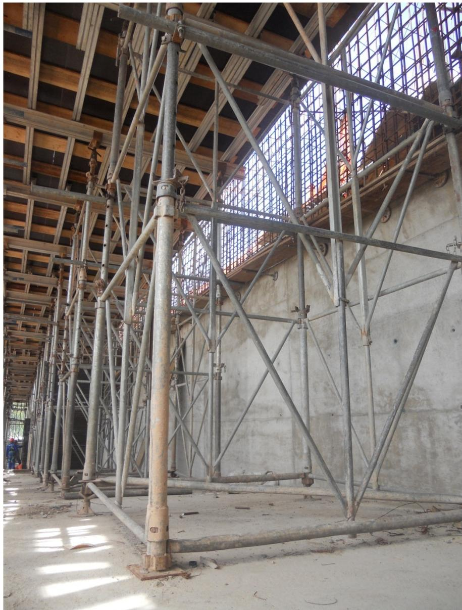
Figura 46 - Posicionamento usual das hastes nas torres
