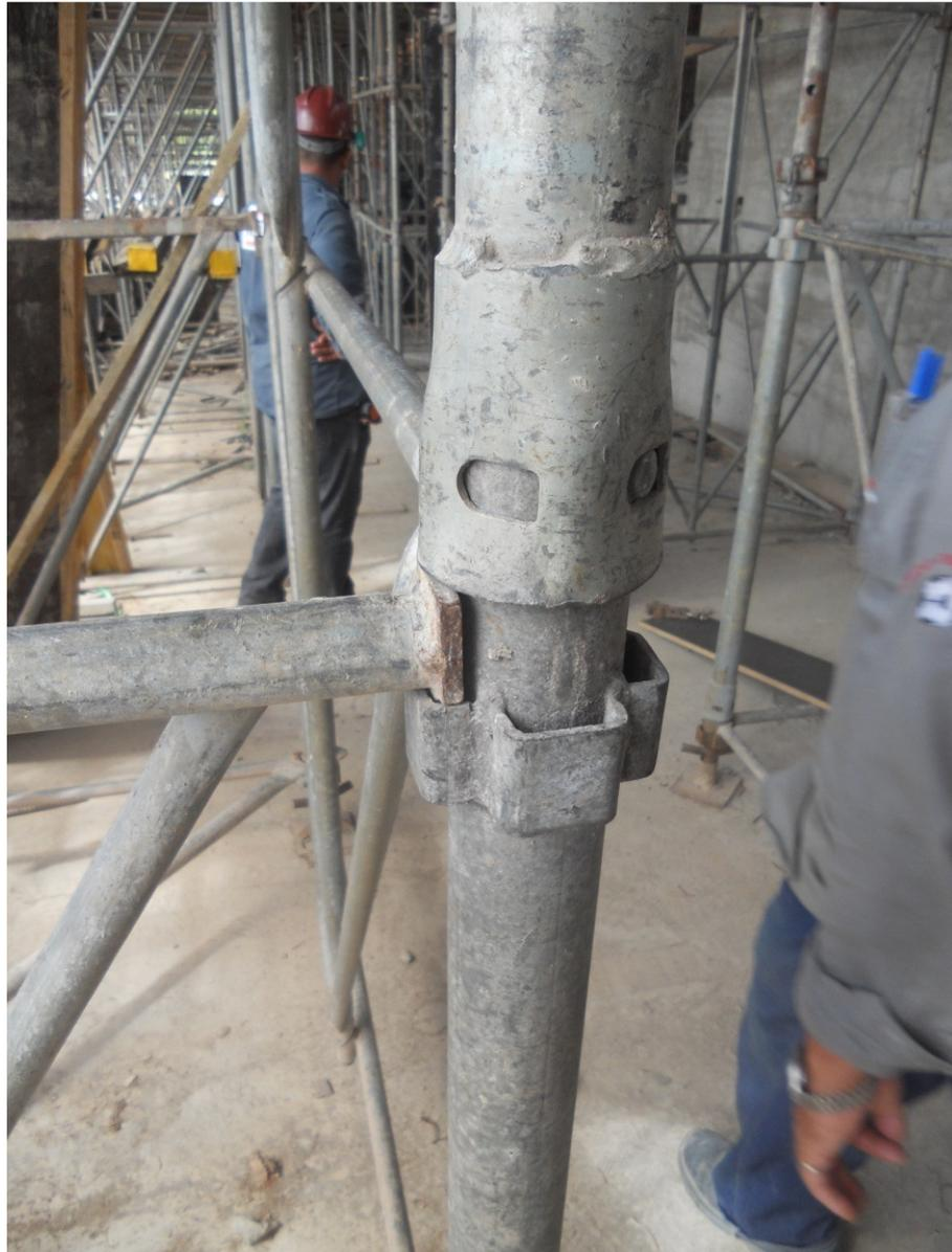
**Figura 65 - Conexão lateral por encaixe**
