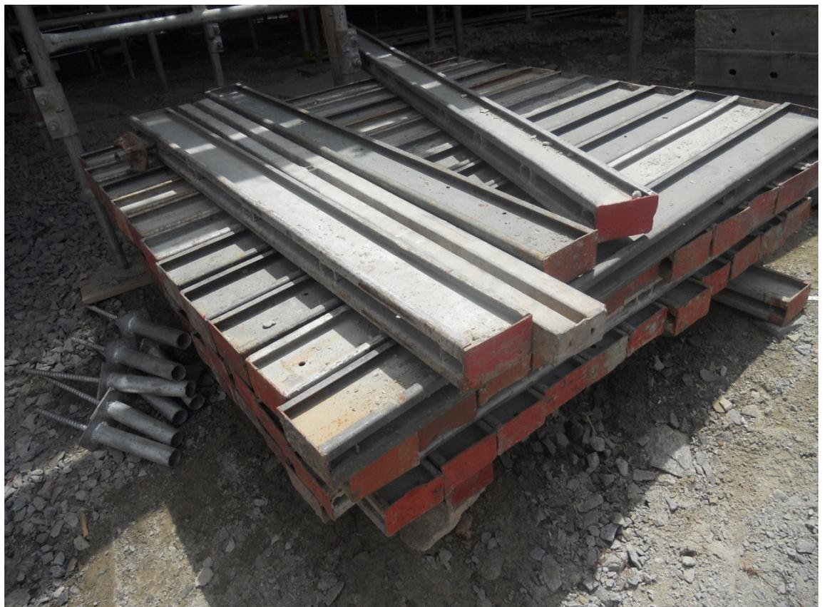
Figura 7 - Perfis indicados para as vigas primárias
