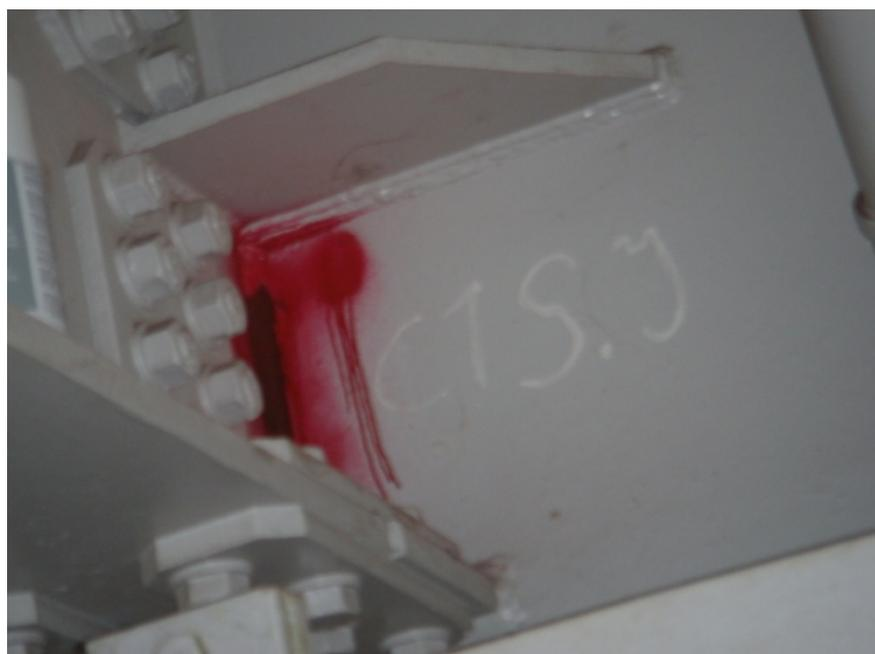
Verificação de soldadura em elementos de ligações aparafusadas
