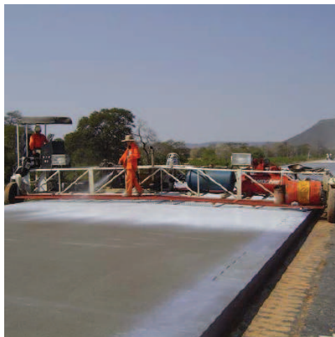
Figura 13: Exemplo de aplicação de agente de cura. (Fonte: ABCP, 2009)
