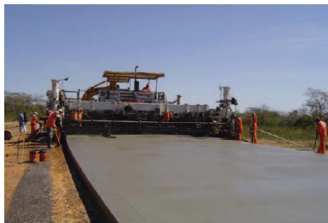
Figura 10: Exemplo de acabamento da placa de concreto. (Fonte: ABCP, 2009)
