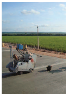
Figura 12: Exemplo de corte de juntas (Fonte: ABCP, 2009)
