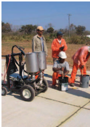
Figura 14: Exemplo de selagem de juntas (Fonte: ABCP, 2009)
