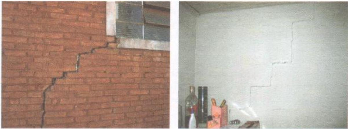
**Figura 2 – Ocorrência de trincas e fissuras nas edificações ocasionadas por recalque (Fonte: Rodrigues, 2007 e Acervo IG-SMA, 2009)**
