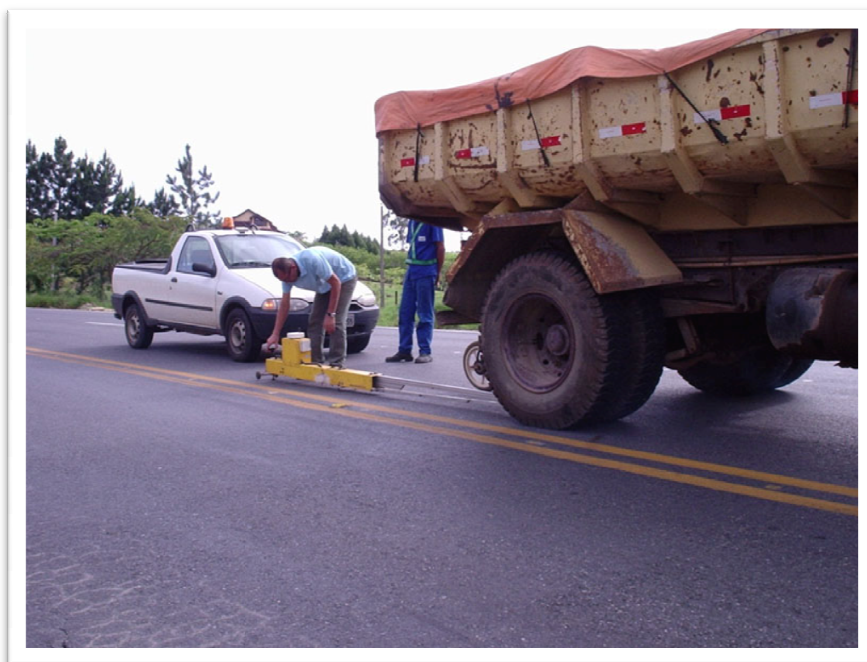
Figura 2.9: Medição com viga Benkelman.
