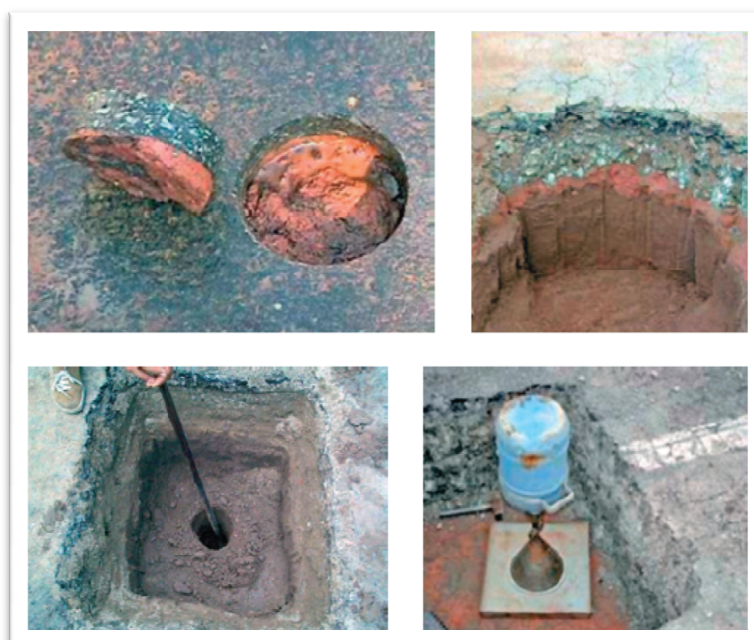
Figura 2.5: Extração do corpo-de-prova e de poços de sondagem em pavimentos (BERNUCCI et al, 2008).
