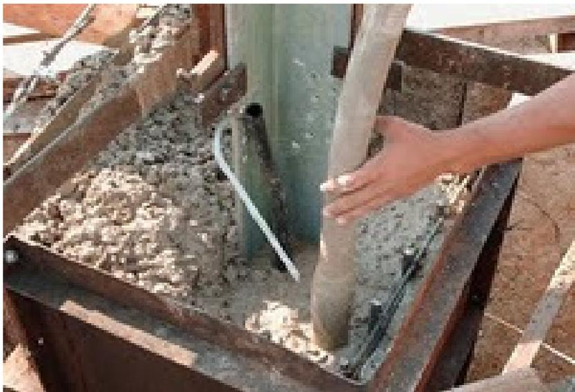
Figura 12- Vibração do concreto
