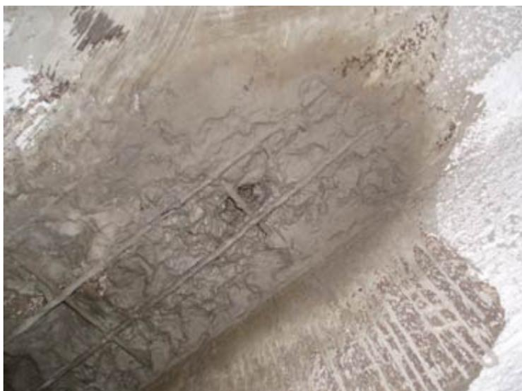
**Figura 15- Concreto segregado**
