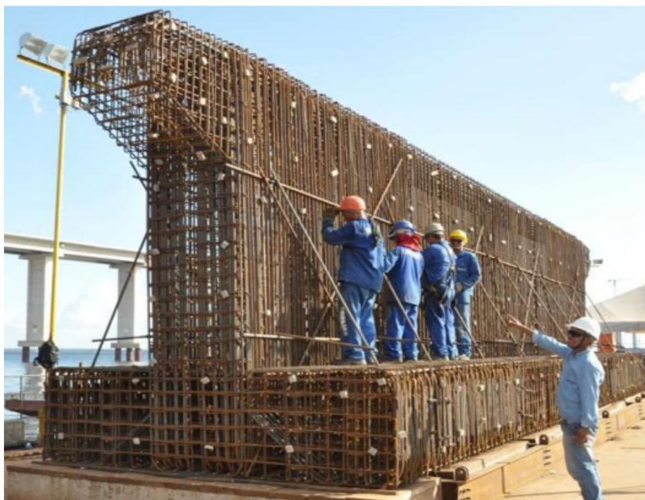
**Figura 9- Armadura para peça pré-moldada**
