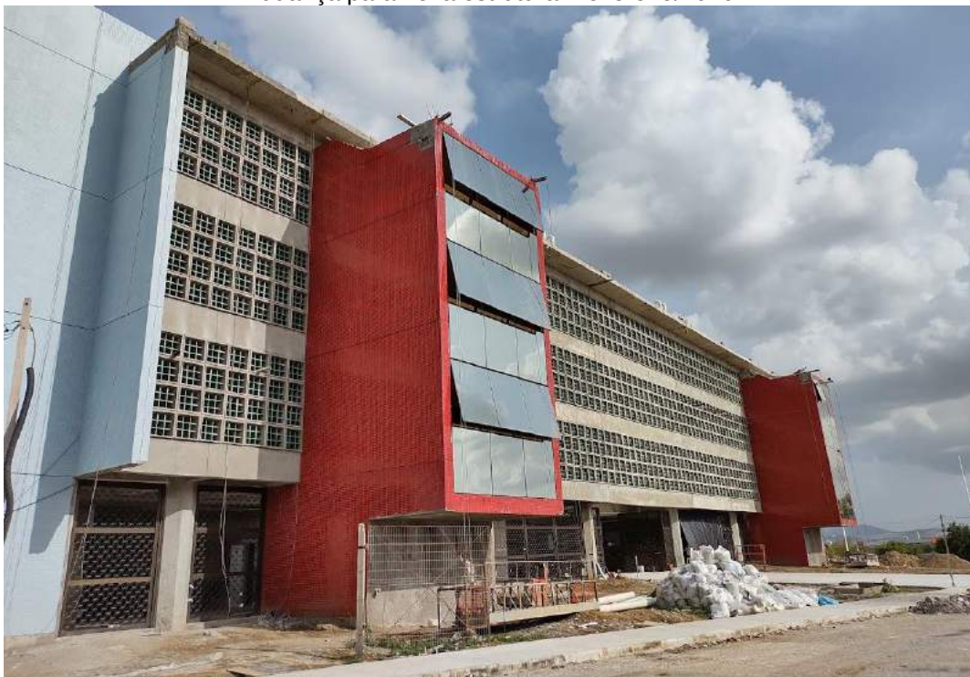
Fotografia 32 - Sede do curso em fase final de construção, momento da entrega da sede provisória e mudança para nova estrutura. Fevereiro/2020.
