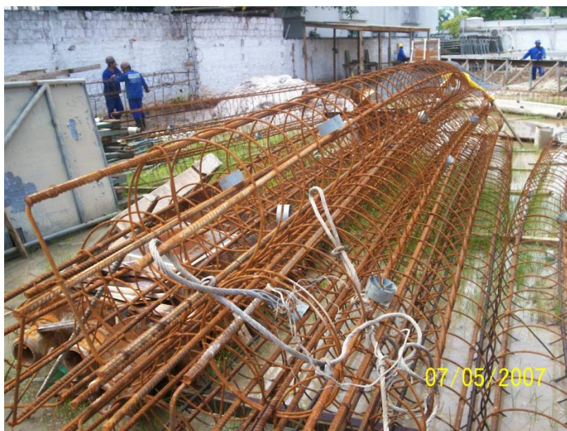
Figura 2.7 – Armadura de estaca hélice contínua com espaçadores plásticos
