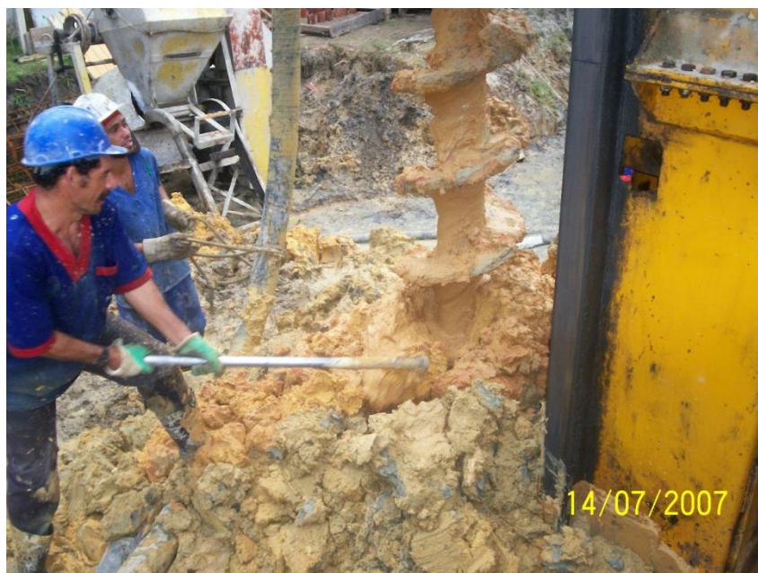
Figura 2.5 – Limpeza do trado durante a execução da estaca
