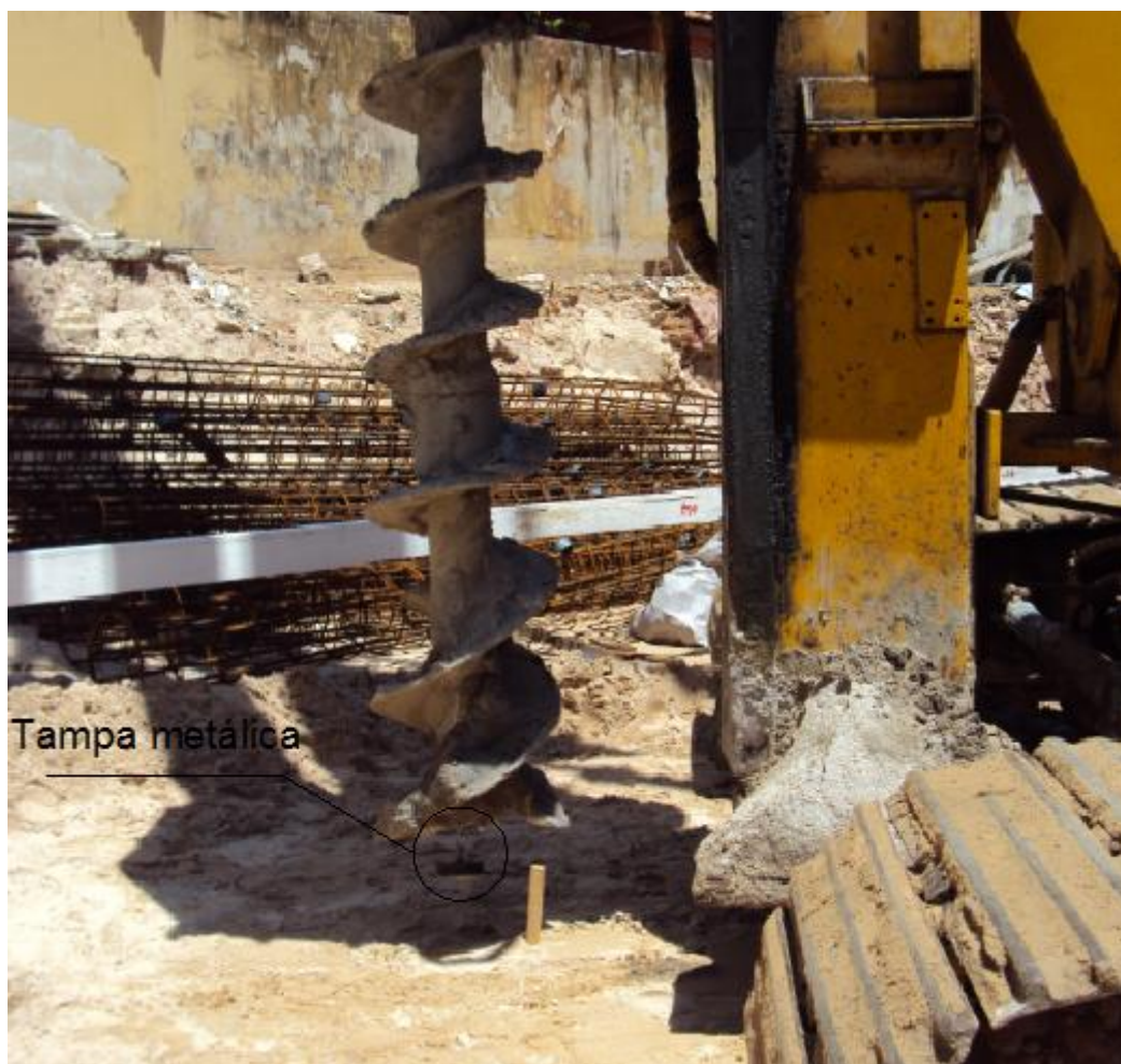
Figura 2.4 – Tampa metálica recuperável
