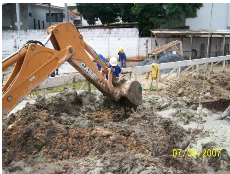
Figura 2.6 – Limpeza do terreno através de uma retroescavadeira após a concretagem da estaca.
