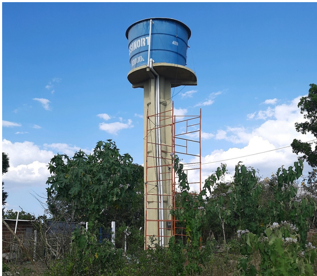
Fotografia 4 - Reservatório elevado da Associação União e Confiança do Sítio Malhada Branca.
