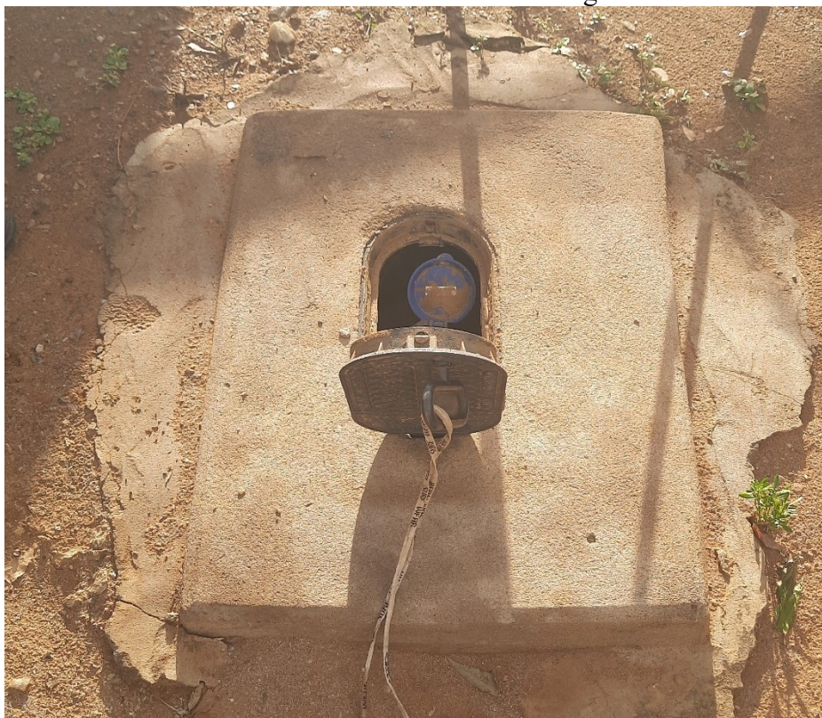
Fotografia 5 - Hidrômetro de uma residência na Associação dos Pequenos Trabalhadores Rurais da Comunidade de São Miguel.
