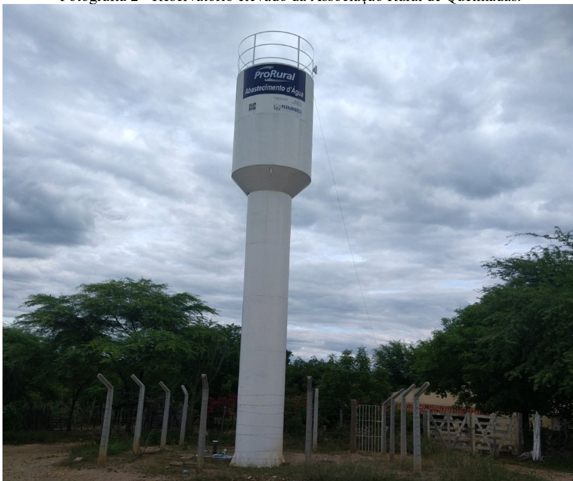
Fotografia 2 - Reservatório elevado da Associação Rural de Queimadas.
