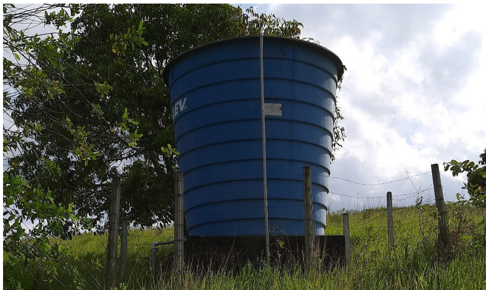
Fotografia 6 - Caixa d'água utilizada para a rede distribuição da Associação dos Trabalhadores Rurais do Assentamento Antônio Conselheiro.
