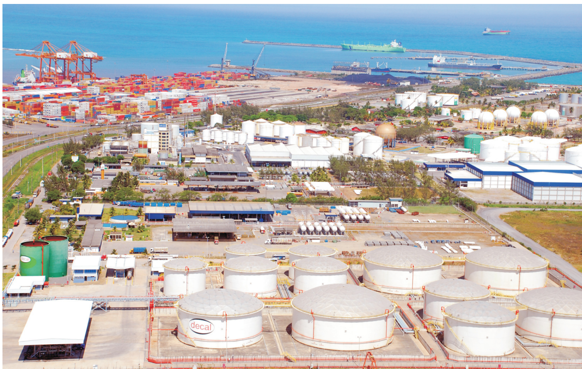
Figura 4.2 – Vista aérea do Complexo Industrial de Suape Fonte: Suape (2008b)
