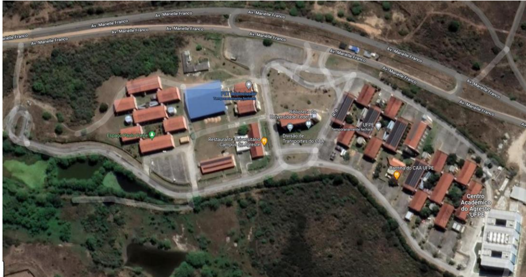
Figura 8 - Imagem aérea do Centro Acadêmico do Agreste (CAA/UFPE)
