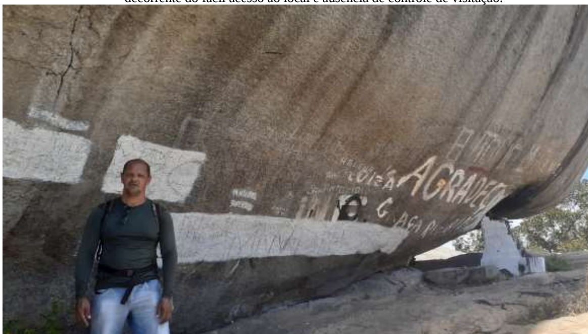
Figura 40 - Base da Pedra do Bico (G2) com pichações em ato de violação ao geopatrimônio, fato decorrente do fácil acesso ao local e ausência de controle de visitação.
