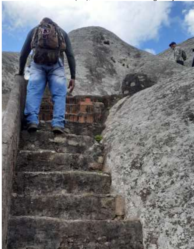
Figura 41 - Acesso a Pedra do Navio (G3), com ausência de segurança e má infraestrutura.
