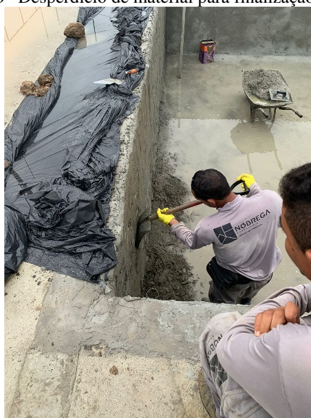
Figura 13 – Desperdício de material para finalização do reboco
