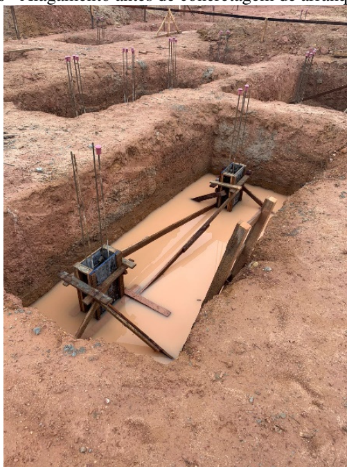
Figura 10 – Alagamento antes de concretagem de arranque de pilar
