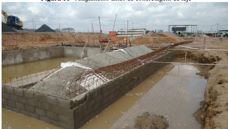
Figura 11 – Alagamento antes de concretagem de laje
