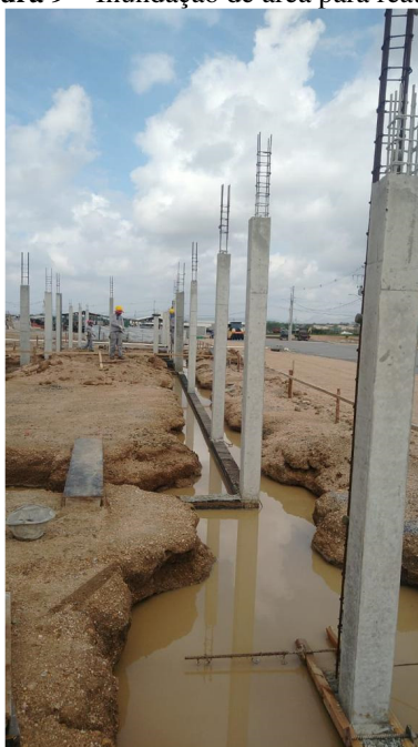
Figura 9 – Inundação de área para reaterro
