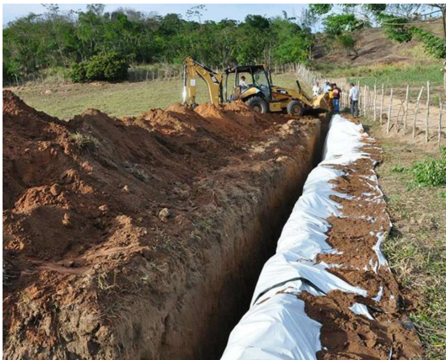
Figura 6 – Colocação do septo impermeável na trincheira
