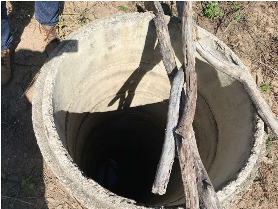
Figura 8 – Poço amazonas constituído de anéis de concreto
