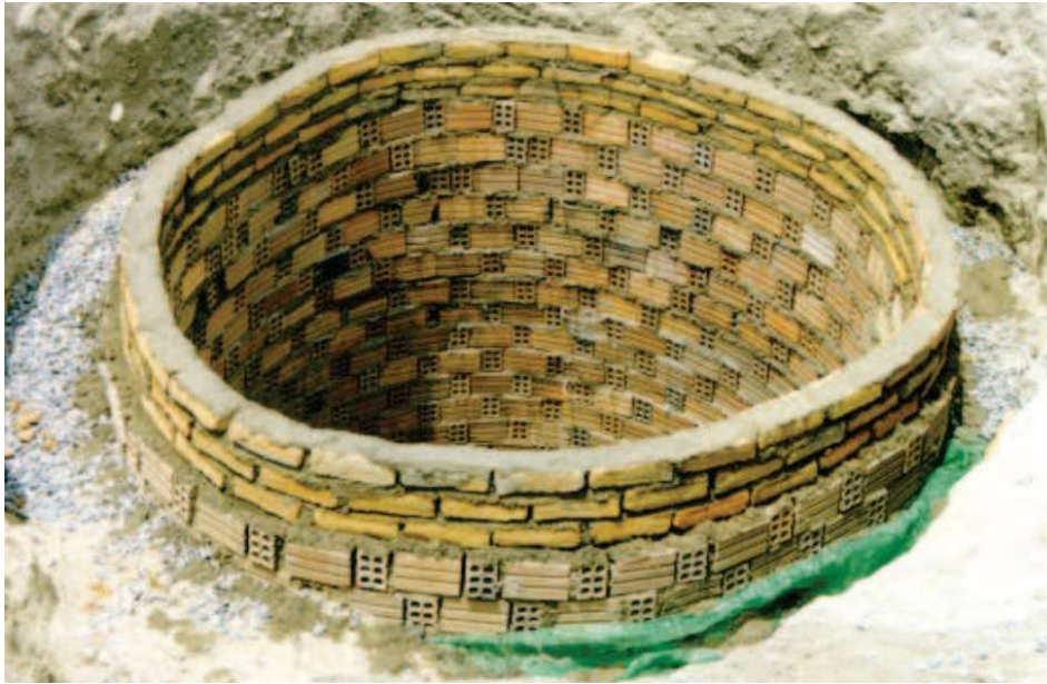
Figura 7 – Poço amazonas constituído de tijolo cerâmico
