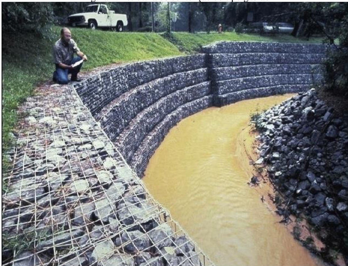
Figura 1. Estrutura de contenção do tipo gabião
