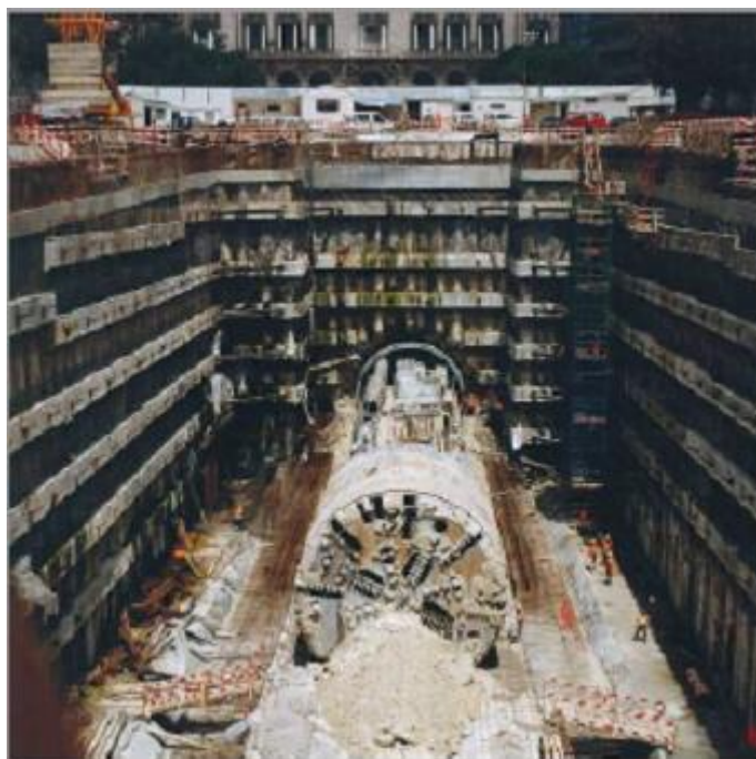
Figura 9. Cortina de estacas com vigas de coroamento e intermédias.
