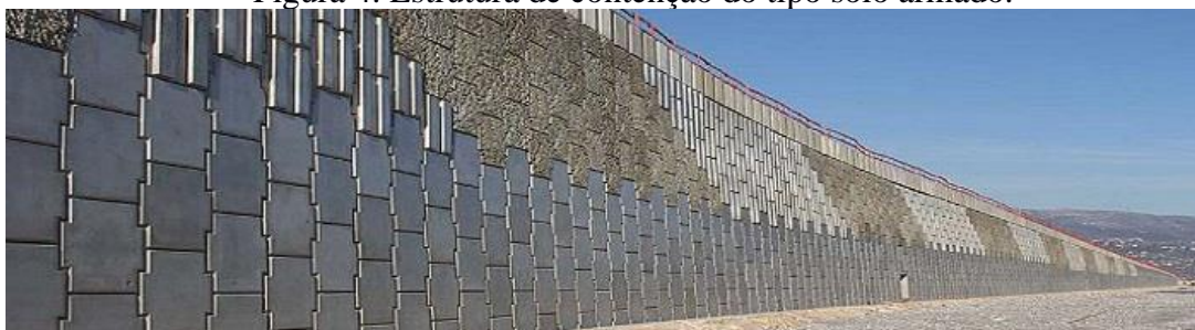
Figura 4. Estrutura de contenção do tipo solo armado.
