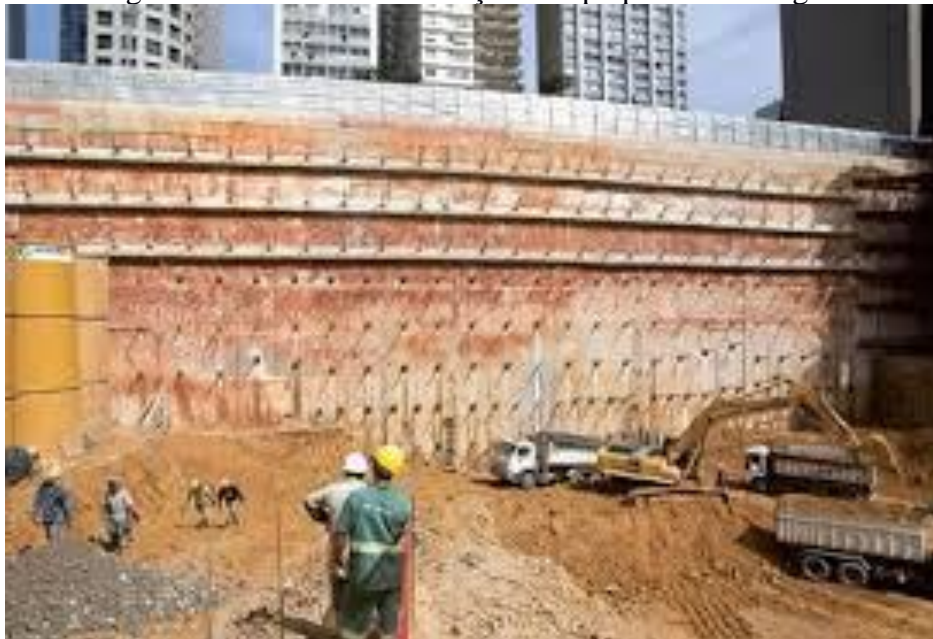
Figura 2. Estrutura de contenção do tipo parede-diafragma
