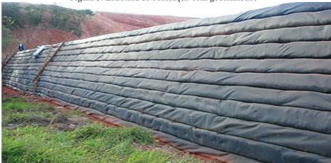
Figura 5. Estrutura de contenção com geossintético
