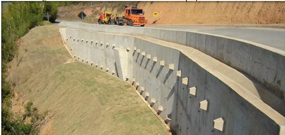
Figura 3. Estrutura de encosta em estrada do tipo parede atirantada.
