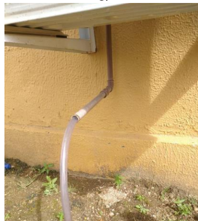
Figura 7 - Tubulação de Coleta da Condensadora Número 1.
