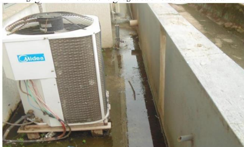
Figura 2 - Destino aleatório de água da unidade condensadora.
