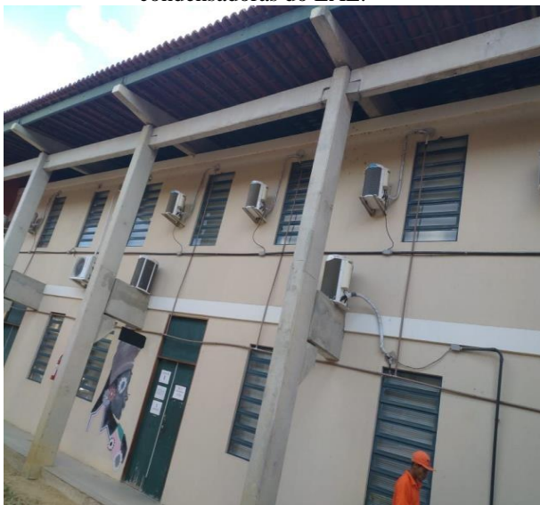
Figura 10 - Tubulação de drenagem das condensadoras do EAE.
