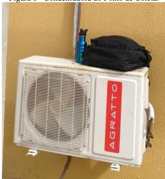
Figura 8 - Condensadora do Ponto de Coleta.
