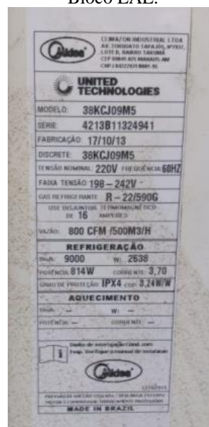
Figura 13 - Especificações da Condensadora do Bloco EAE.
