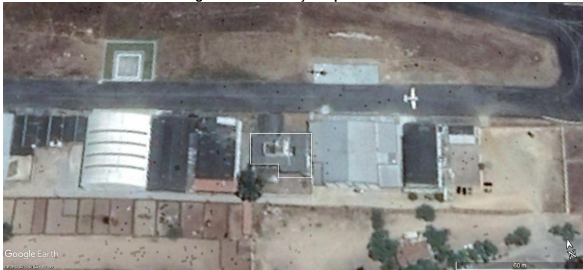
Figura 14 - Instalações para o SESCINC
