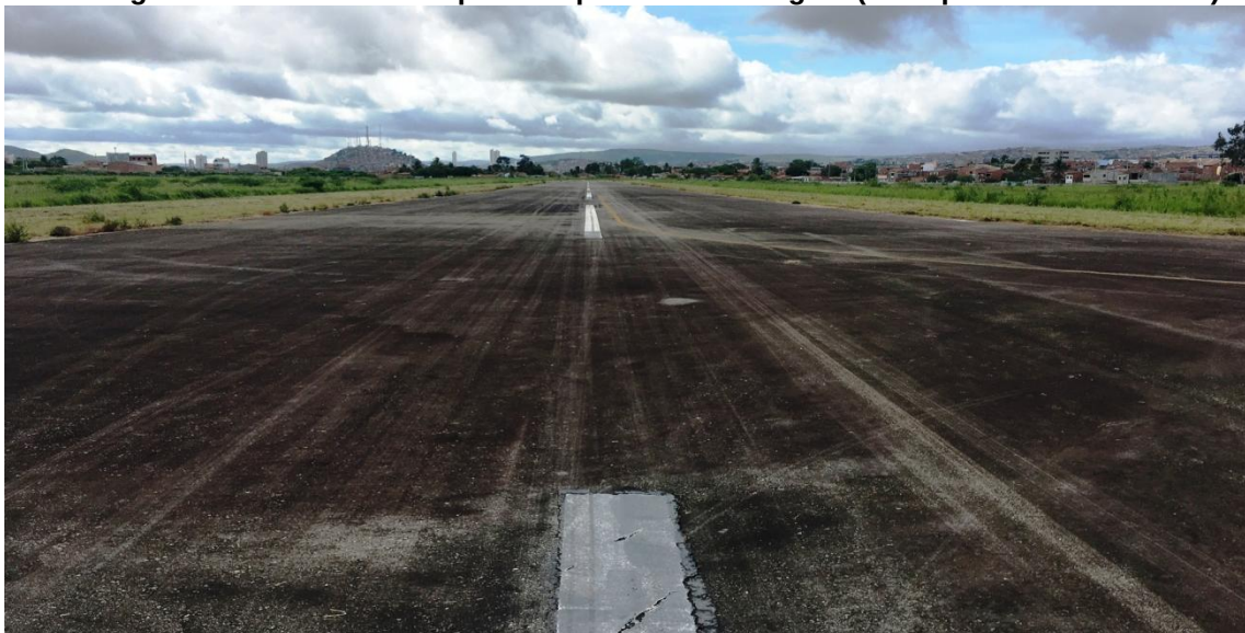
Figura 22 - Pavimento da pista de pouso e decolagem (vista para a cabeceira 31)
