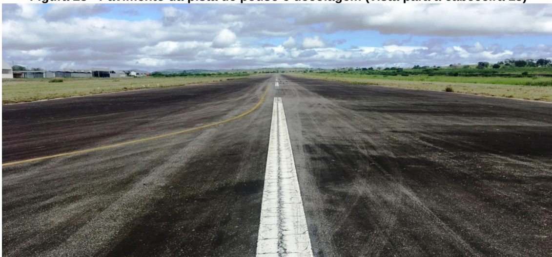
Figura 23 - Pavimento da pista de pouso e decolagem (vista para a cabeceira 13)
