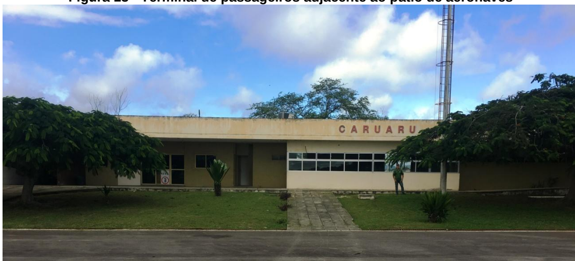
Figura 13 - Terminal de passageiros adjacente ao pátio de aeronaves
