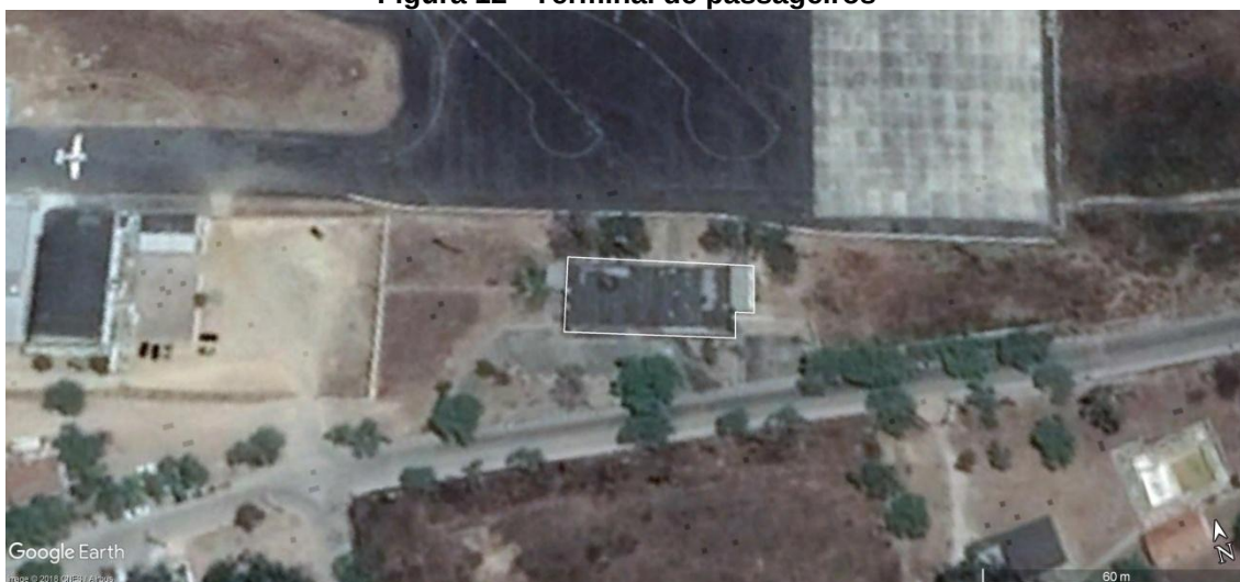
Figura 12 - Terminal de passageiros
