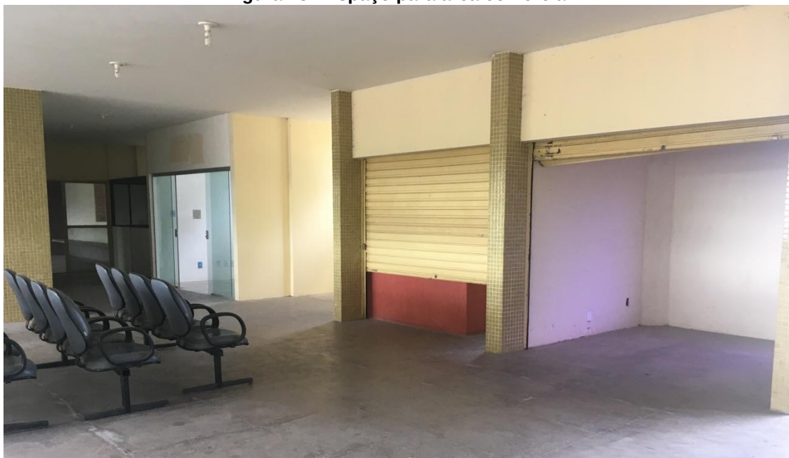
Figura 28 - Espaço para área comercial
