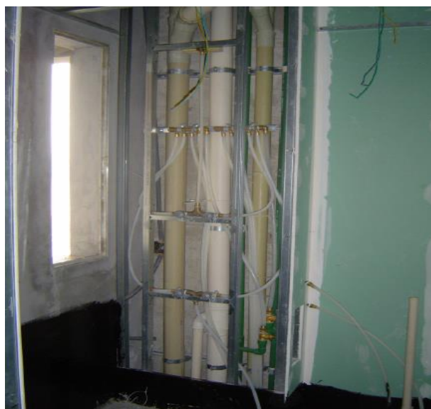
Figura 54: Shaft numa residência em drywall e LSF.
