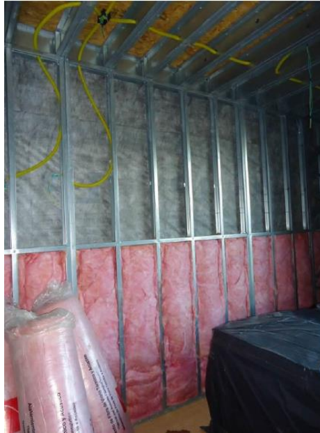
Figura 48: Instalação de lã de vidro em painel.
