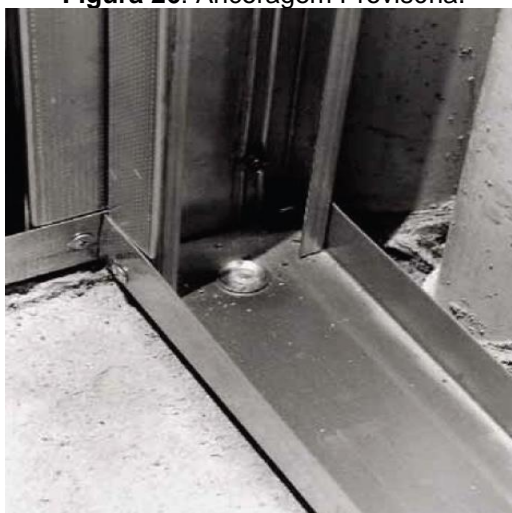
Figura 26: Ancoragem Provisória.
