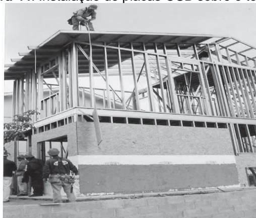
Figura 44: Instalação de placas OSB sobre o telhado.
