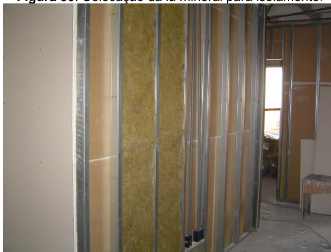
Figura 50: Colocação da lã mineral para isolamento.
