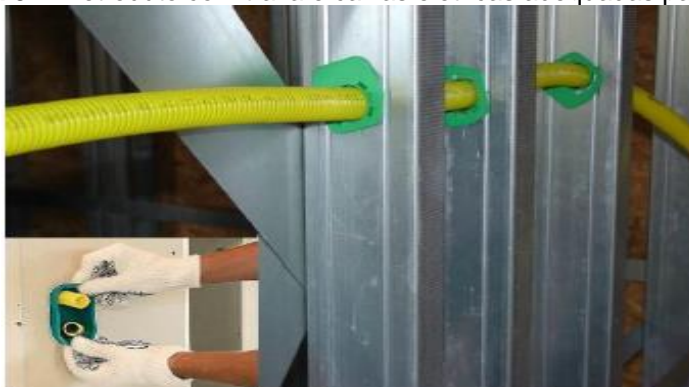
Figura 57: Eletroduto com trava e caixas elétricas adequadas para LSF.
