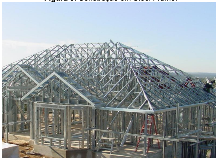
Figura 3: Construção em Steel Frame.
