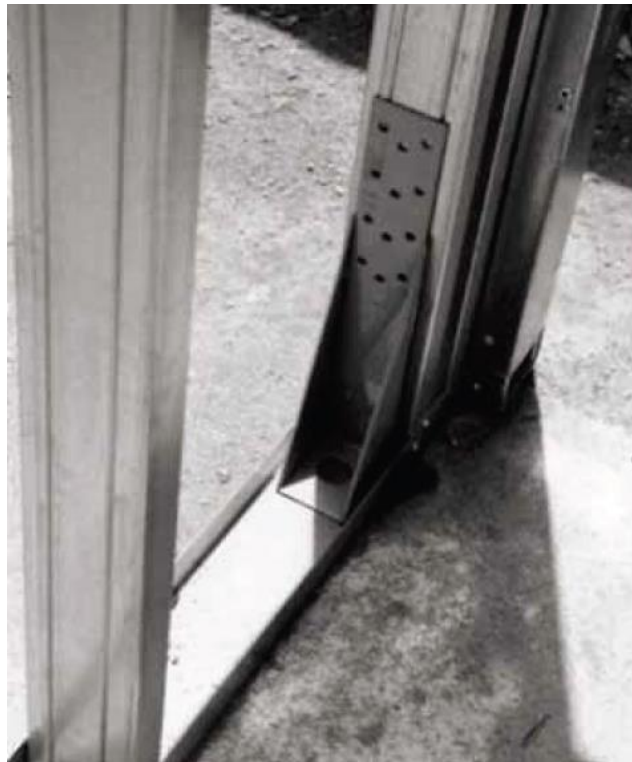
Figura 23: Detalhe da peça de reforço na ancoragem da estrutura à fundação por meio de barra rosca.
