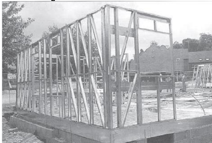
Figura 46: Contraventamento em K.
