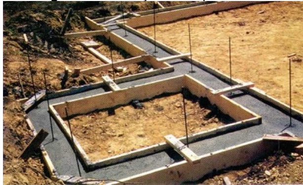
Figura 27: Fundação em sapata corrida
