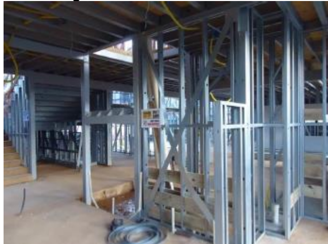
Figura 45: Contraventamento em X.
