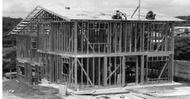
Figura 2: Estrutura de Residência em LSF em São Paulo.
