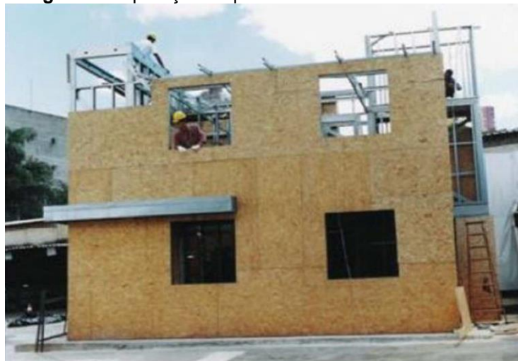
Figura 21: Aplicação de placas OSB em uma residência.
