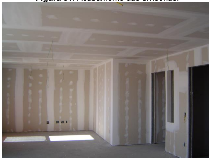
Figura 51: Acabamento das divisórias.
