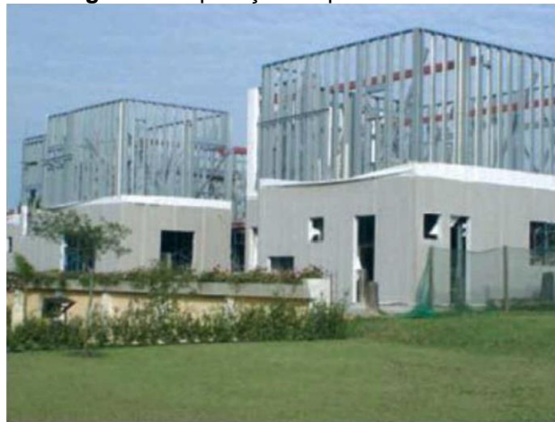
Figura 22: Aplicação de placa cimentícia.
