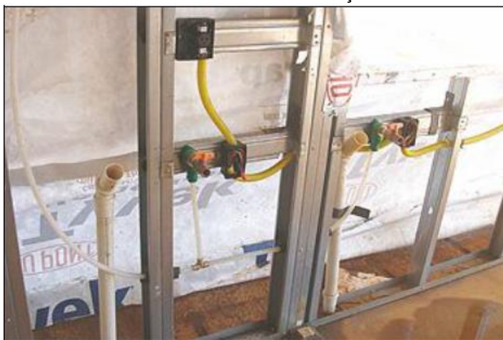
Figura 52: Paredes em Steel Frame com instalações elétricas e hidráulicas.
