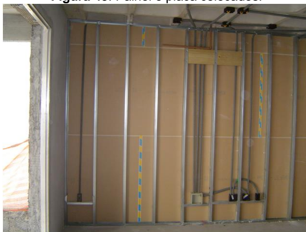
Figura 49: Painel e placa colocados.
