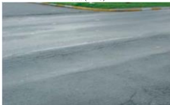
23(c) Afundamento plástico nas trilhas de roda (ATP)
