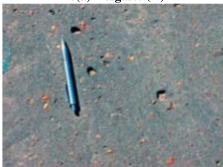
26(c) Deslocamento e perda de agregados
