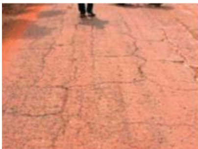
22(e) Trincas de bloco com erosão (TBE)
