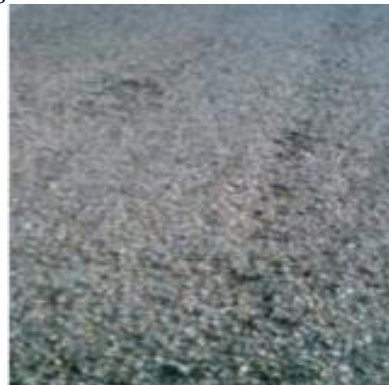
26(b) Desagregação (D)
