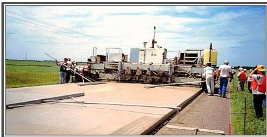
Figura 6 Execução de um pavimento rígido
