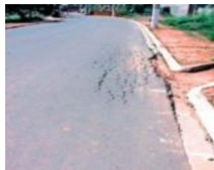
23(b) Afundamento por consolidação localizado (ALC)
