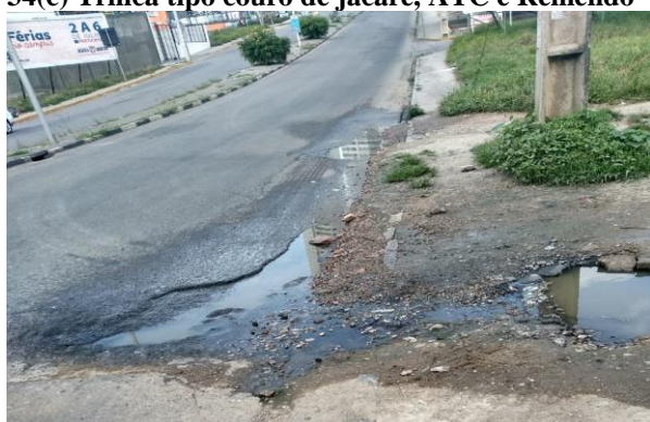
34(e) Presença de água degradando o pavimento
