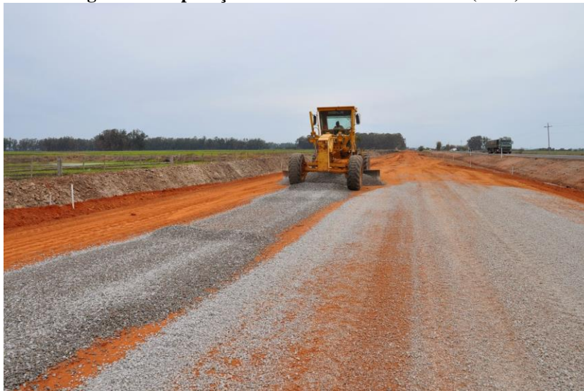
Figura 14 Preparação da sub-base da BR-116/RS (2013).
