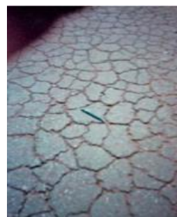
22(h) Trinca tipo couro de jacaré (J)
