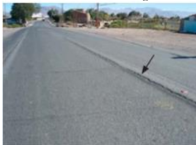
22(c) Trinca de retração (TRR)
