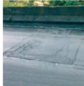
22(d) Trinca de retração (TRR)
