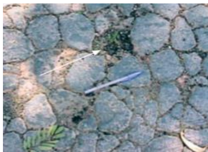
22(g) Trinca tipo couro de jacaré com erosão (JE)
