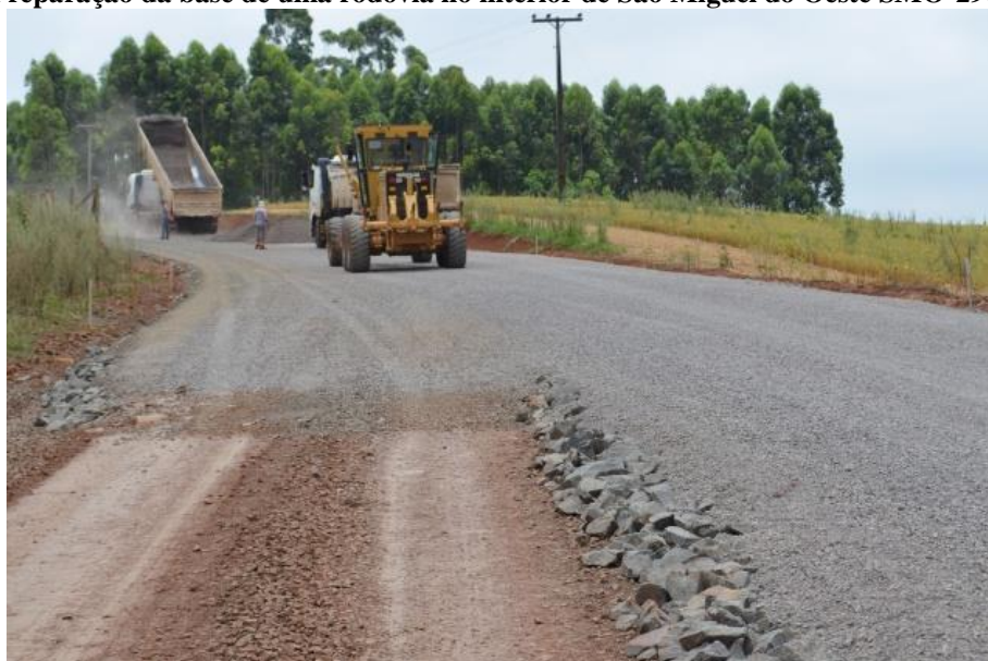
Figura 16 Preparação da base de uma rodovia no interior de São Miguel do Oeste SMO-290 (2016).
