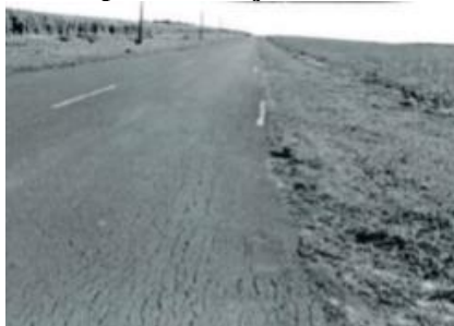
21(i) Conjunto de trincas longitudinais longas
