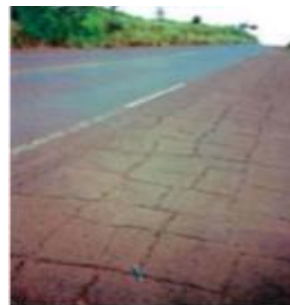
22(f) Trincas de bloco sem erosão (TB)
