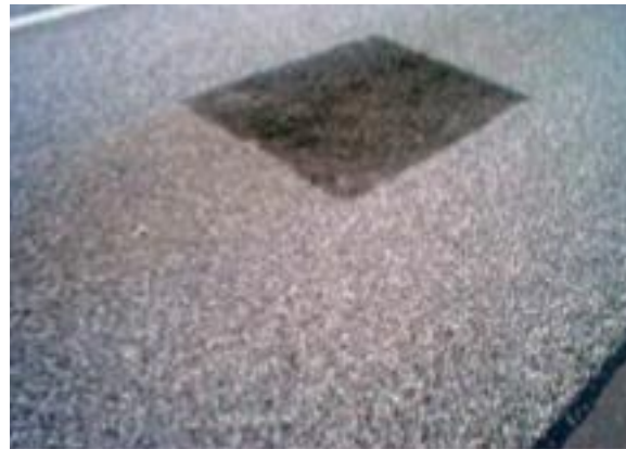
28 (b) Remendo bem executado (R)
