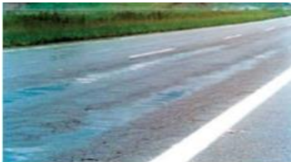
23(a) Afundamento por consolidação em trilha de roda (ATC)
