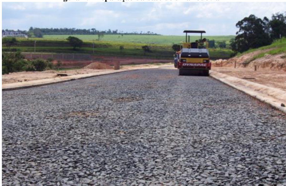
Figura 15 Preparação da base de uma rodovia
