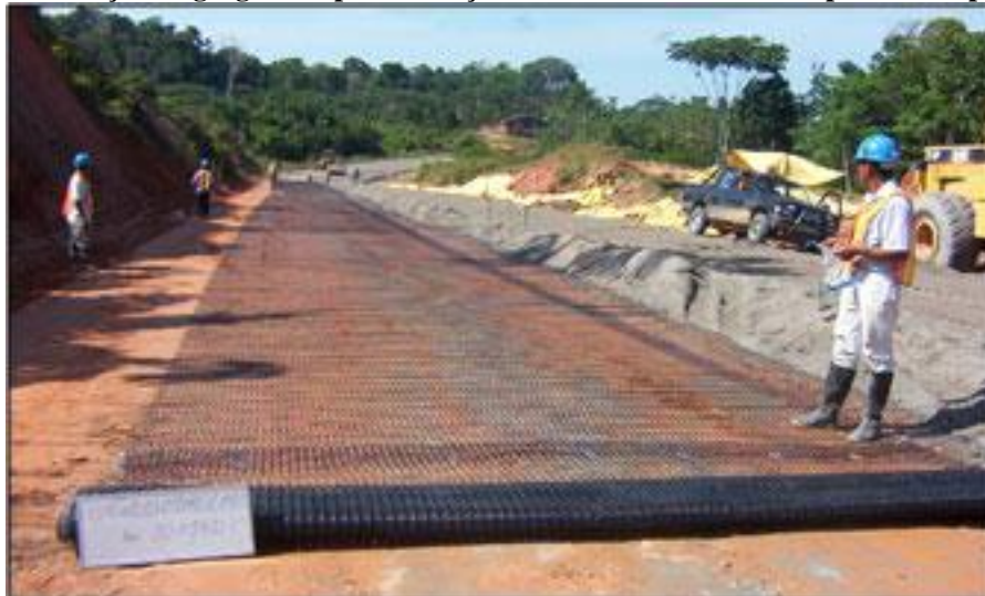
Figura 13 Utilização de geogrelhas para reforço do subleito reduzindo a espessura do pavimento.
