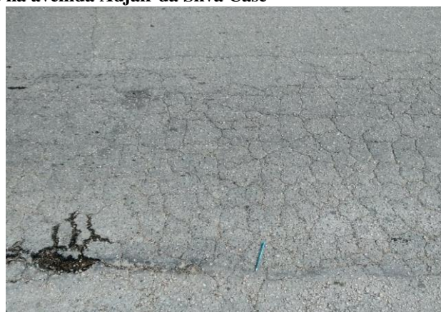
34(b) Trincas tipo couro de jacaré com erosão
