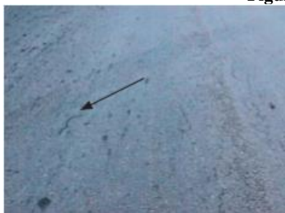
22(a) Trincas isoladas curtas longitudinais (TLC)
