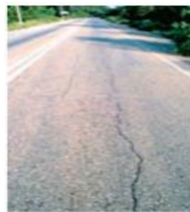
22(b) Trincas longitudinais longas (TLL)
