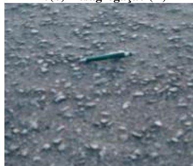
26(d) Polimento de agregado
