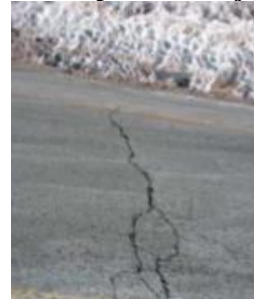
22(j) Trincas de retração
