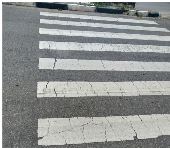
34(d) Trincas transversais curtas (TTC)
