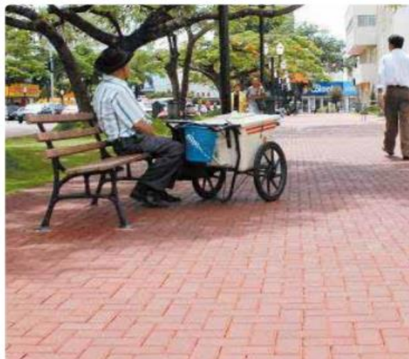
Figura 2 – Pavimentação feita com pavers.
