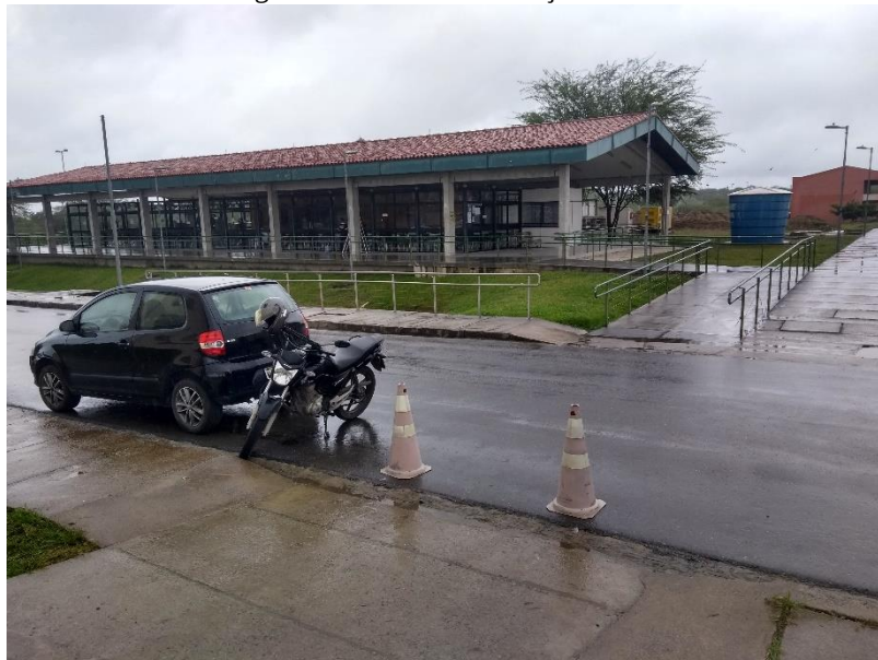
Figura 47 – Falta de indicação do RU
