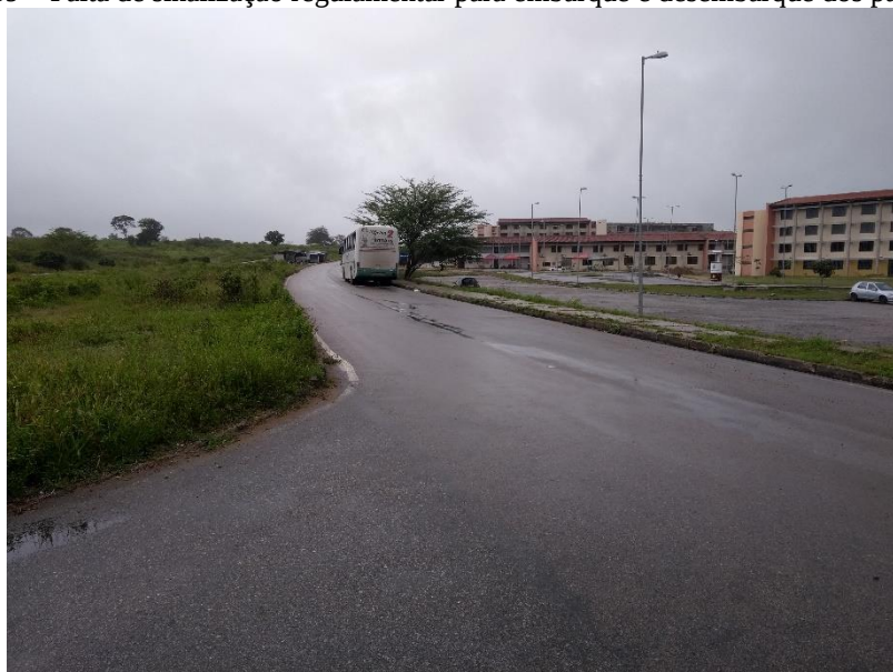
Figura 39 – Falta de sinalização regulamentar para embarque e desembarque dos passageiros
