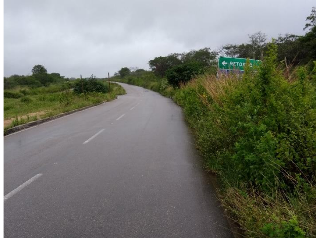
Figura 37 – Placa de indicação na via de acesso ao CAA
