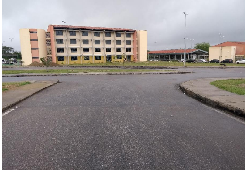
Figura 58 – Entrada do CAA (local onde fazem conversão à esquerda erroneamente)
