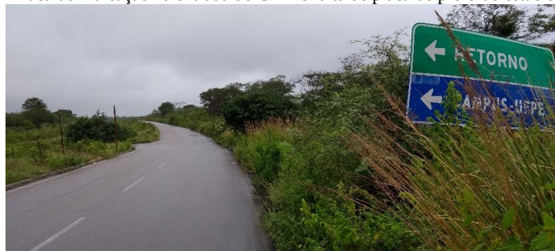
Figura 67 – Placa de indicação na entrada do CAA e falta de placa de proibido estacionar
