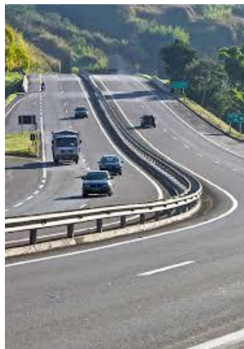
Figura 8 – Barreira metálica central de contenção
