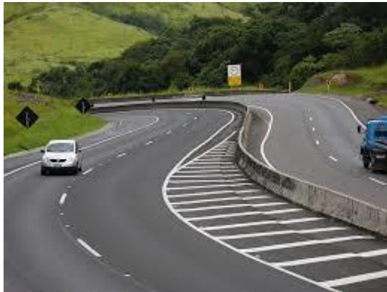
Figura 7 – Canteiro central estreito com barreira física
