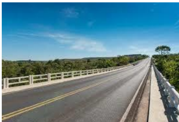
Figura 9 – Barreira de concreto lateral de contenção
