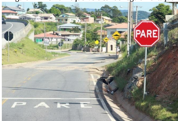
Figura 12 – Sinalização vertical de regulamentação
