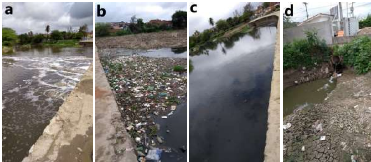
Figura 19 - Fotos do ponto de coleta P4: (a) Situação à jusante com formação de espuma, (b) Acúmulo de lixo à montante, (c) Situação à jusante com formação de gases no leito e (d) Emissário lançando efluentes
