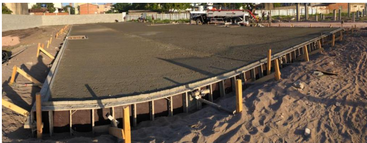
Fotografia 4 - Construção do radier
