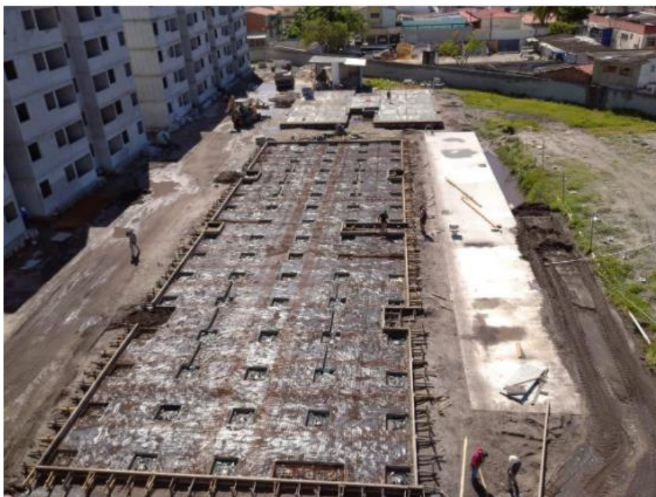
Fotografia 7 - Locação e armação do radier
