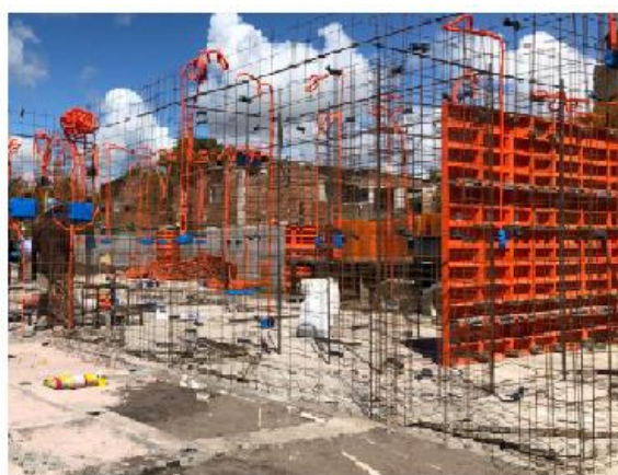
(a) sistema de armação em tela soldáveis.
