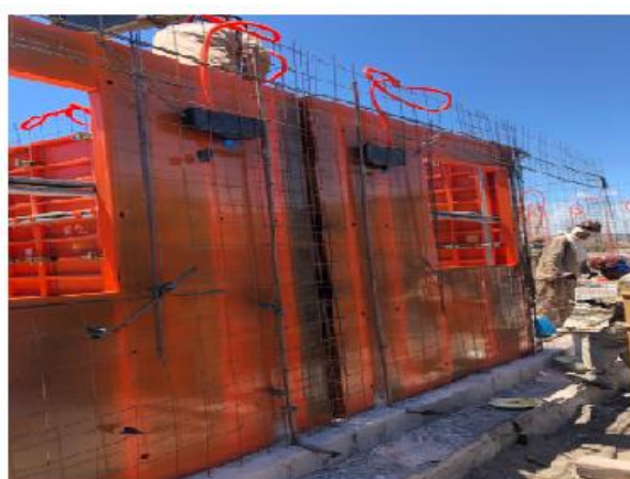
(b) sistema de formas metálicas.
