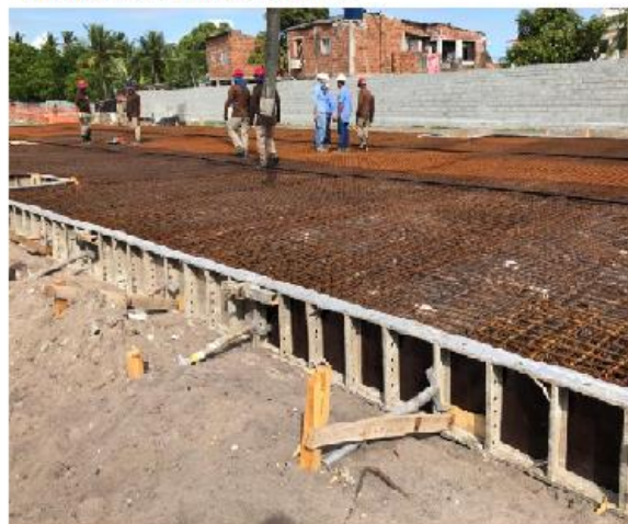
(d) armação e concretagem do radier.
