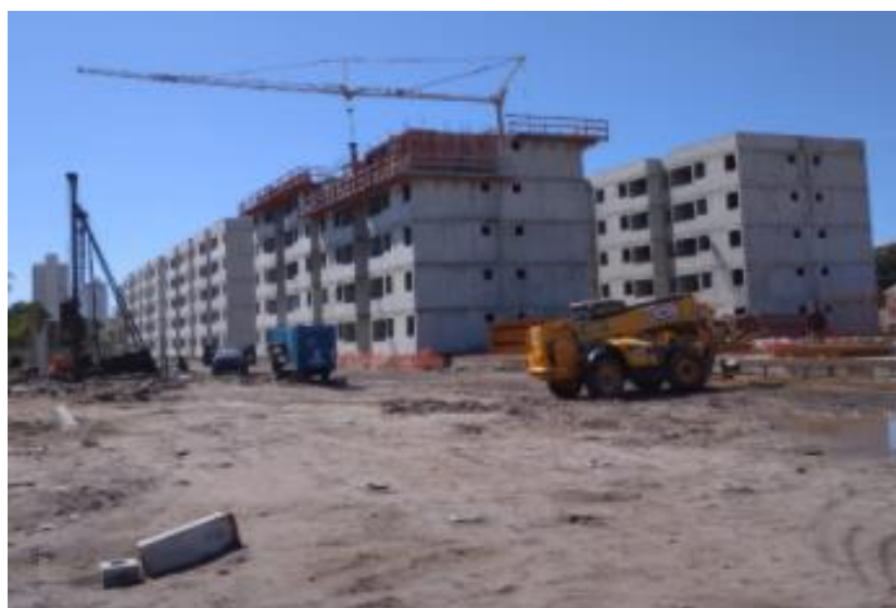
Fotografia 3 - Fachada da estrutura em parede de concreto
