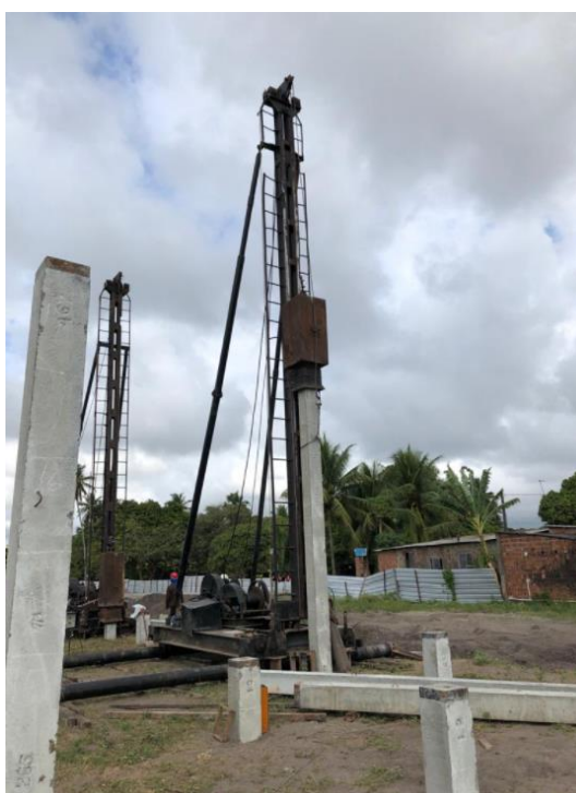
Fotografia 6 - Procedimento de cravação de estacas
