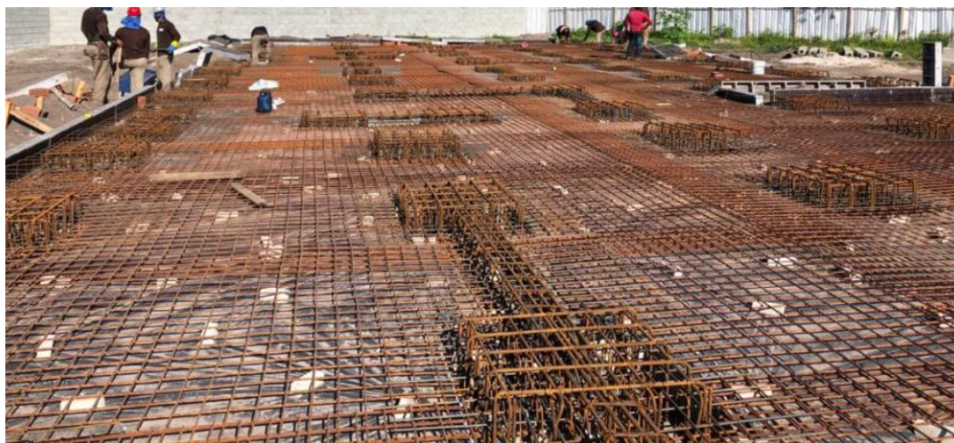
Fotografia 5 – Locação e armação do radier estaqueado
