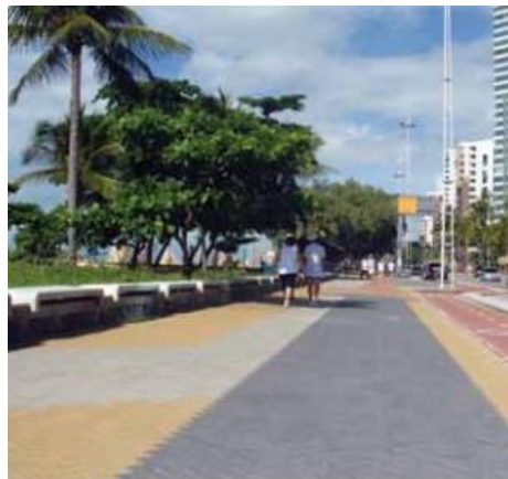
Figura 2: Pavimentação feita com pavers
