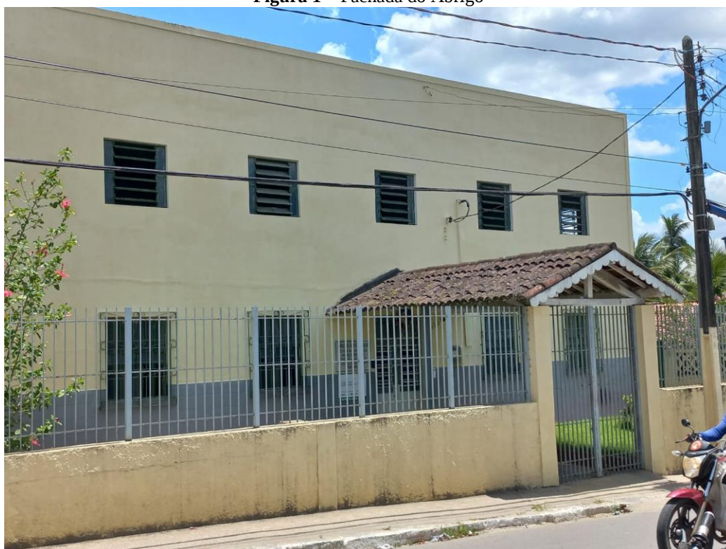
Figura 1 – Fachada do Abrigo
