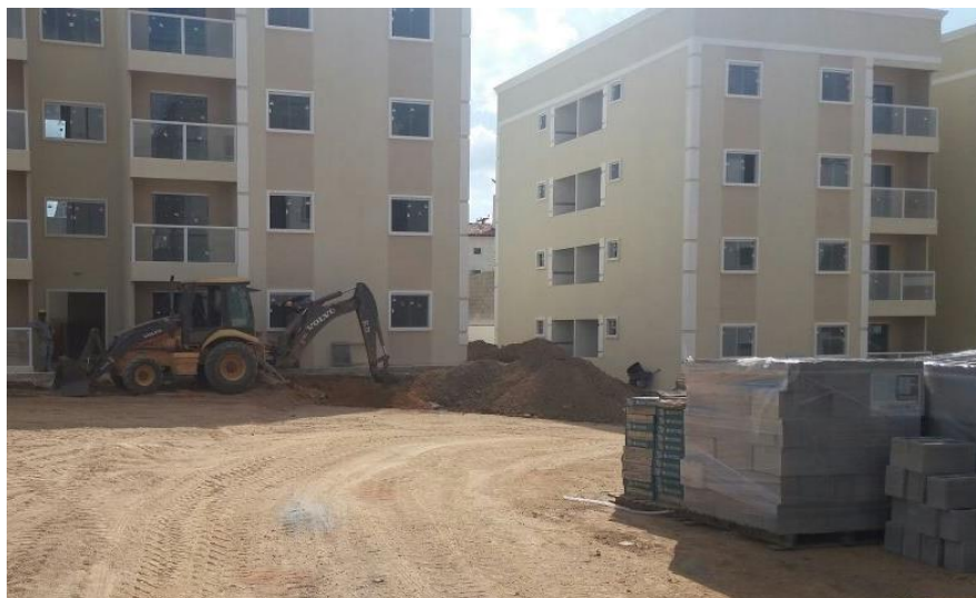
Foto 3: Canteiro de obras
