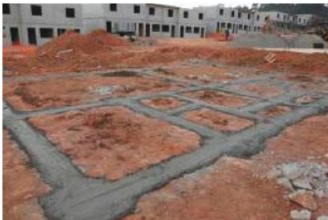
Figura 24: Fundação em sapata corrida
