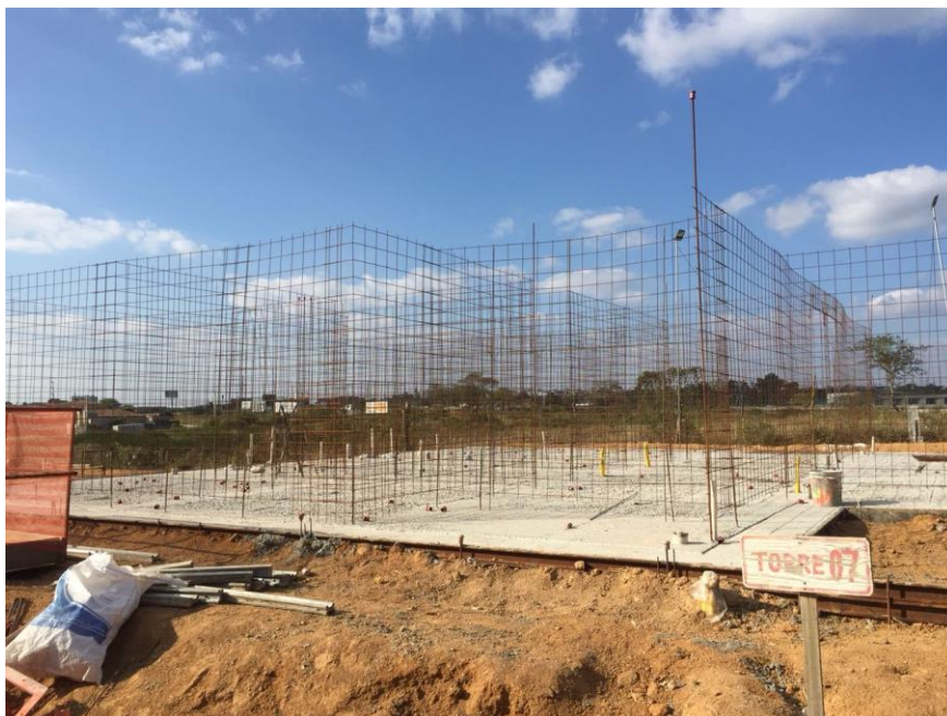
Foto 5: Painéis internos fixados no radier
