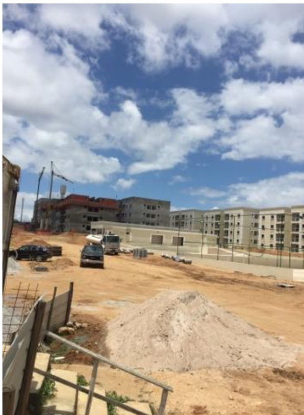
Foto 12: Canteiro de obras
