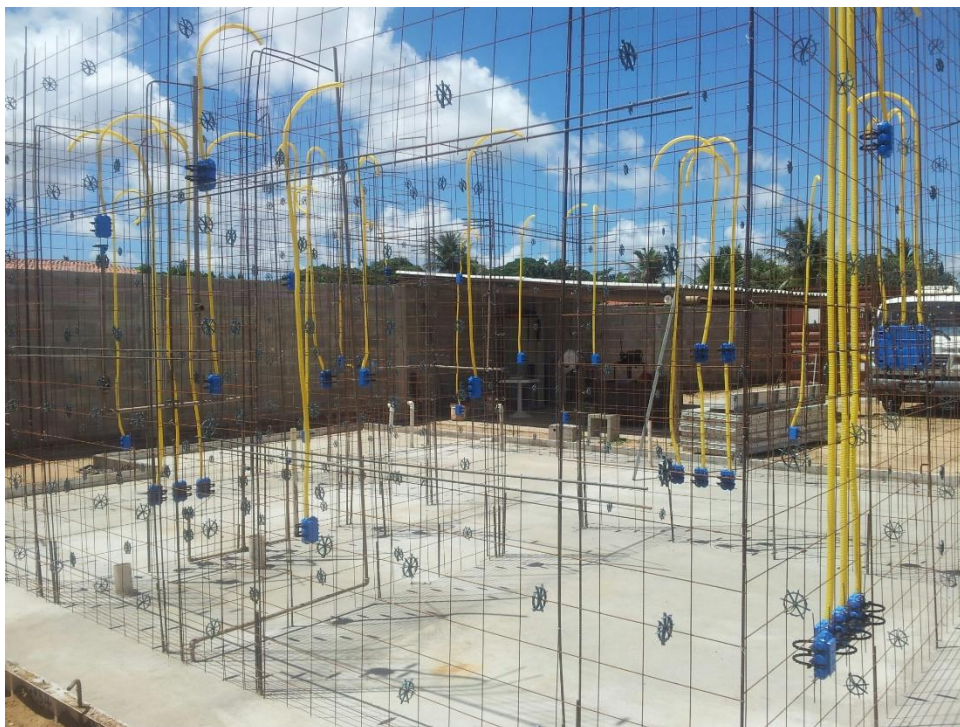
Figura 23: Instalação elétrica completa fixada nos painéis internos
