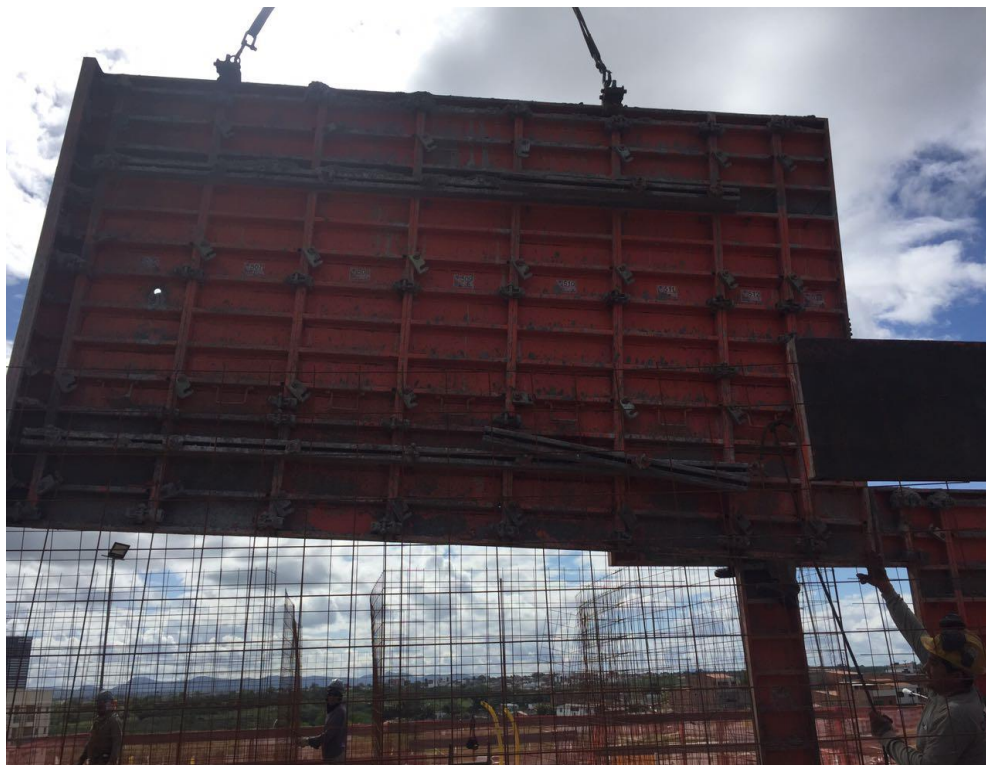
Foto 9: Fôrma sendo posicionada pela grua
