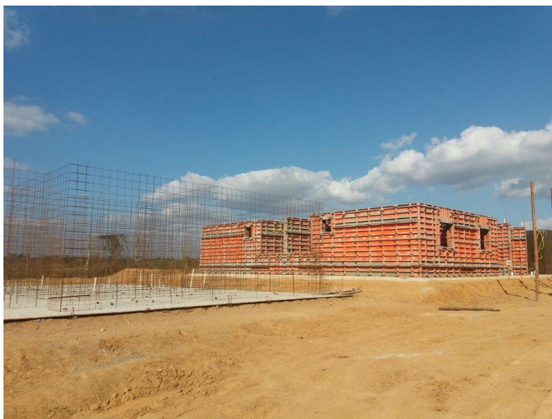
Foto 2: Fôrmas e painéis internos
