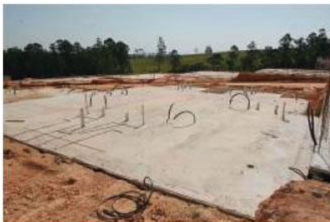
Figura 25: Fundação em radier
