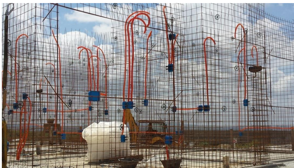
Figura 21: Demonstração da instalação elétrica fixada nos painéis internos
