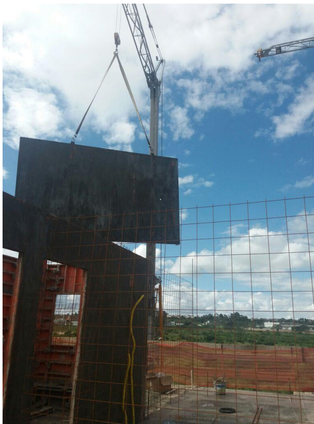
Foto 11: Grua posicionando as fôrmas
