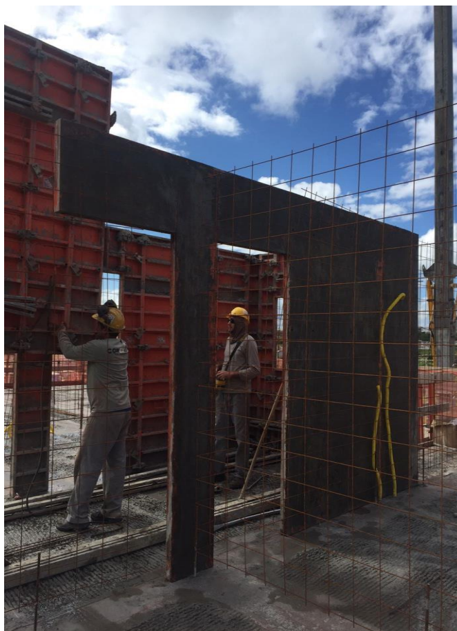
Foto 10: Fôrma sendo posicionada
