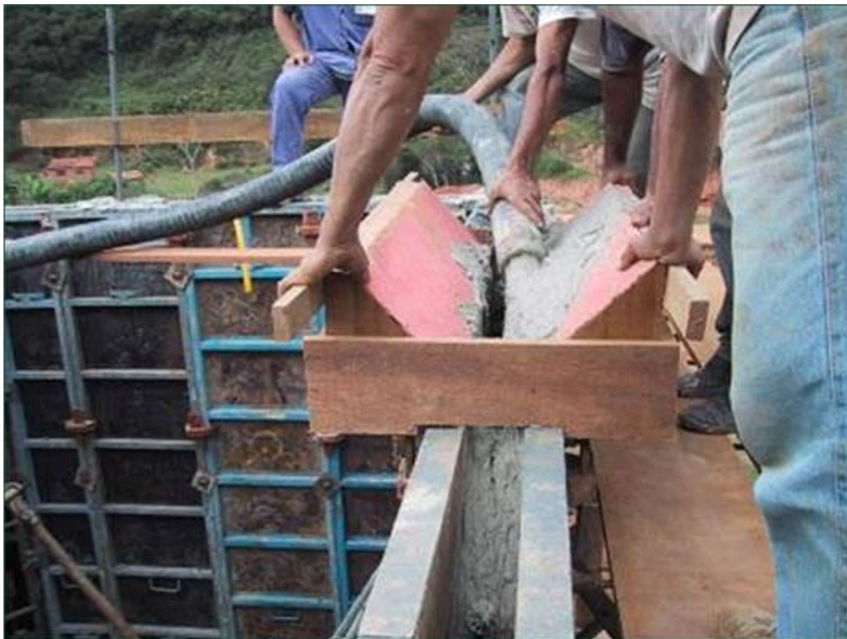
Figura 20: Concretagem de uma parede de concreto
