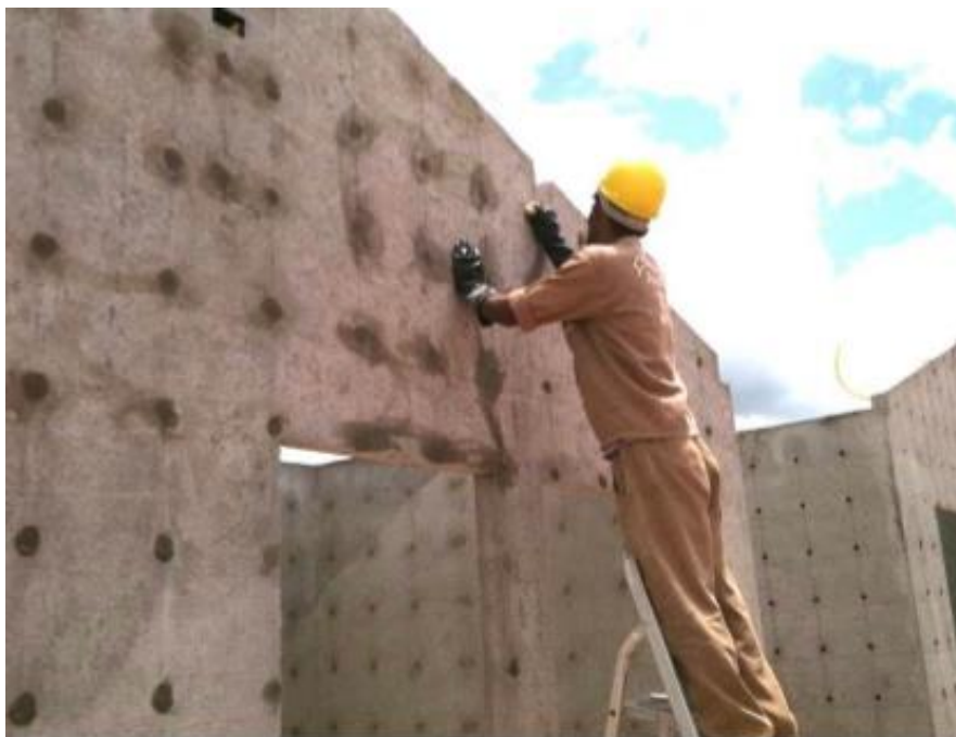
Figura 26: Acabamento em uma parede de concreto moldada “in loco”
