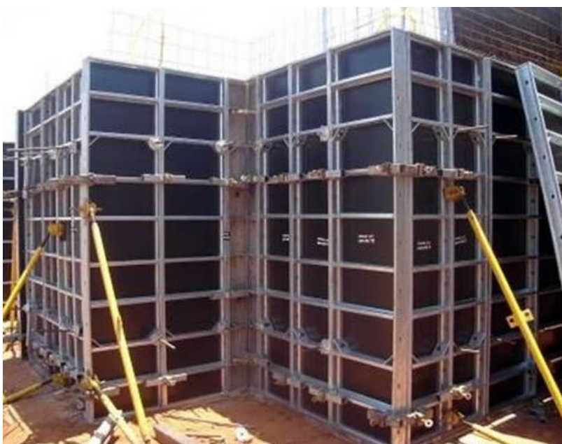
Figura 19: Montagem de fôrmas metálicas
