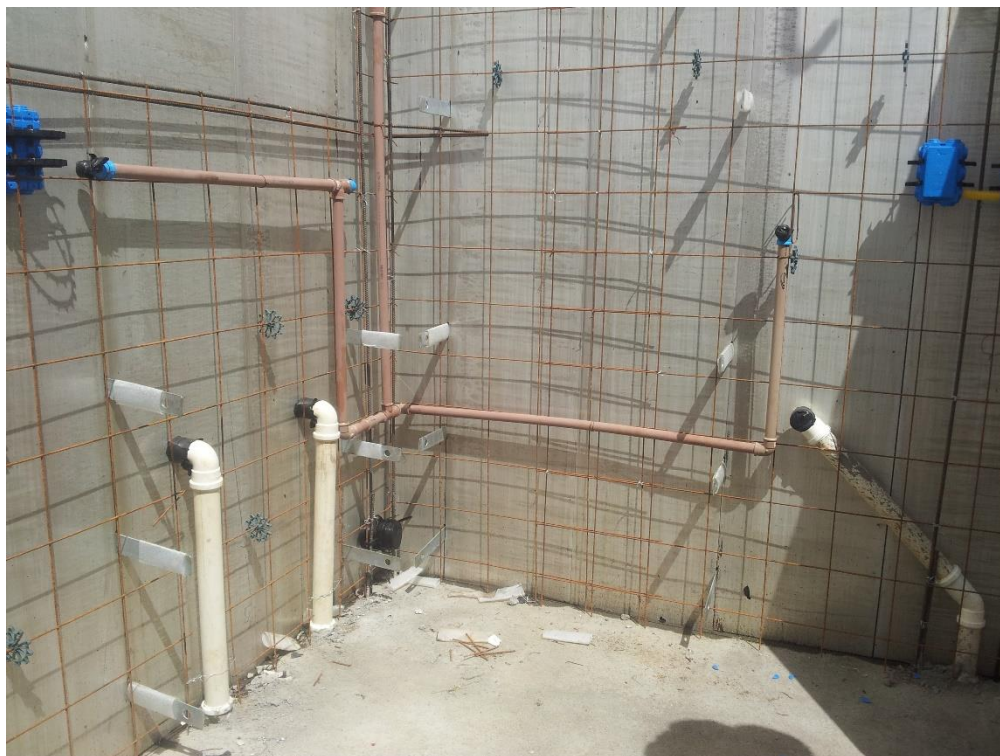
Figura 22: Instalações hidráulicas dispostas no interior das paredes
