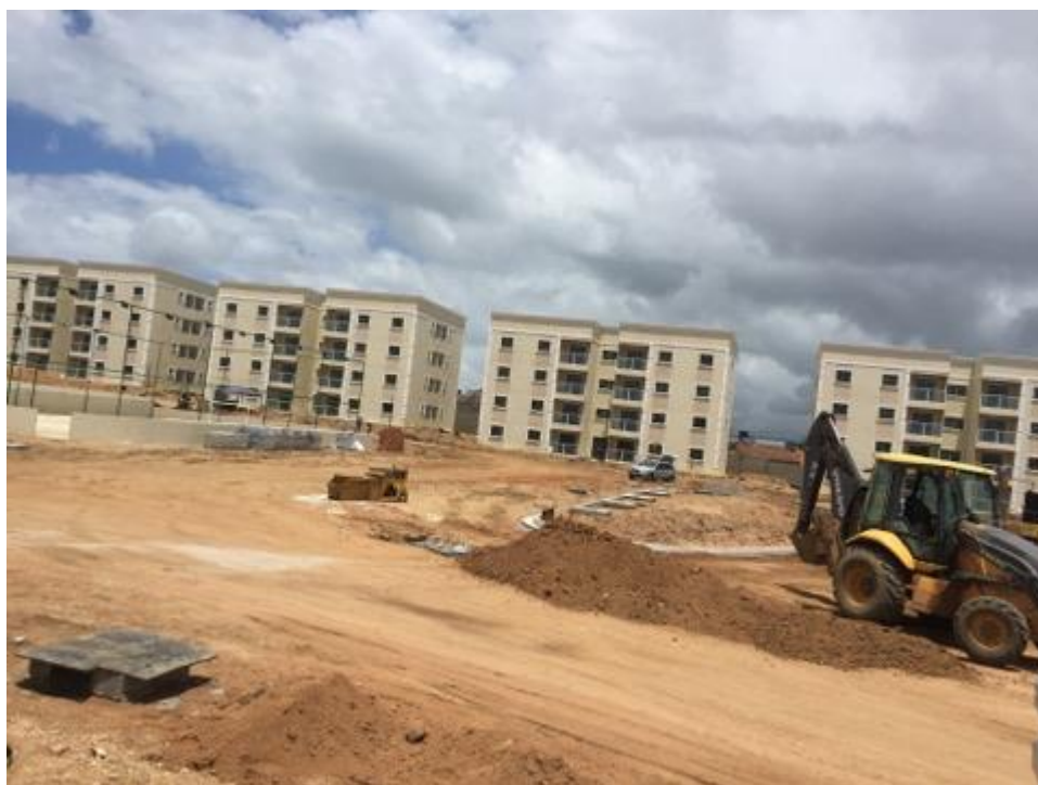
Foto 13: Canteiro de obras
