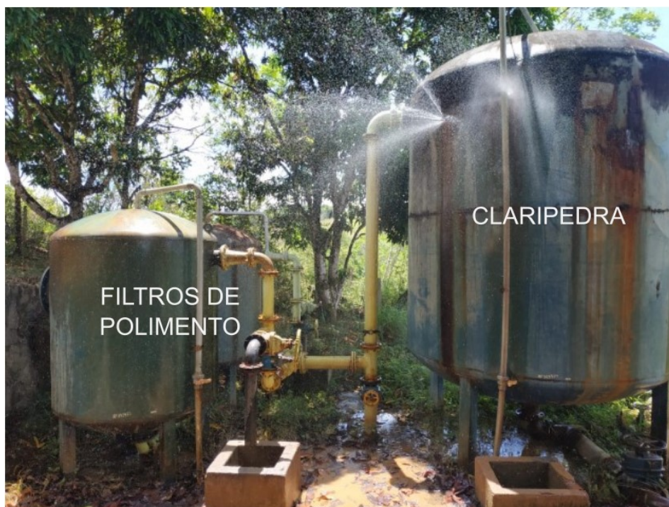
Figura 9 – Vista de partes das instalações da ETA de Batateira - PE.
