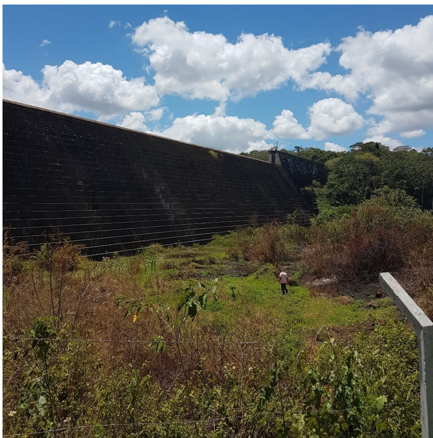
Figura 25 – Rocha aflorante à jusante da barragem do Rio da Prata.
