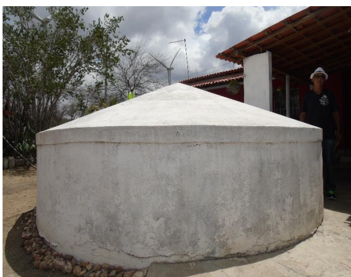
FIGURA 9: Cisterna de placas
