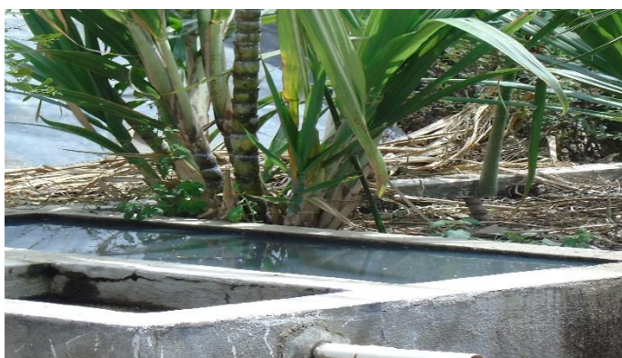
FIGURA 14: Bacia de evapotranspiração ou biorremediação
