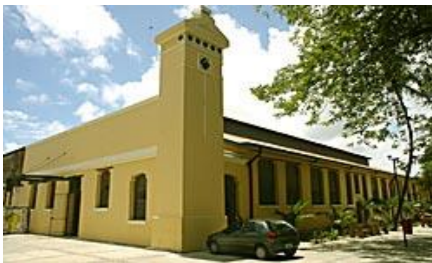
Figura 11 — Prédio de eventos do Nascedouro reformado
