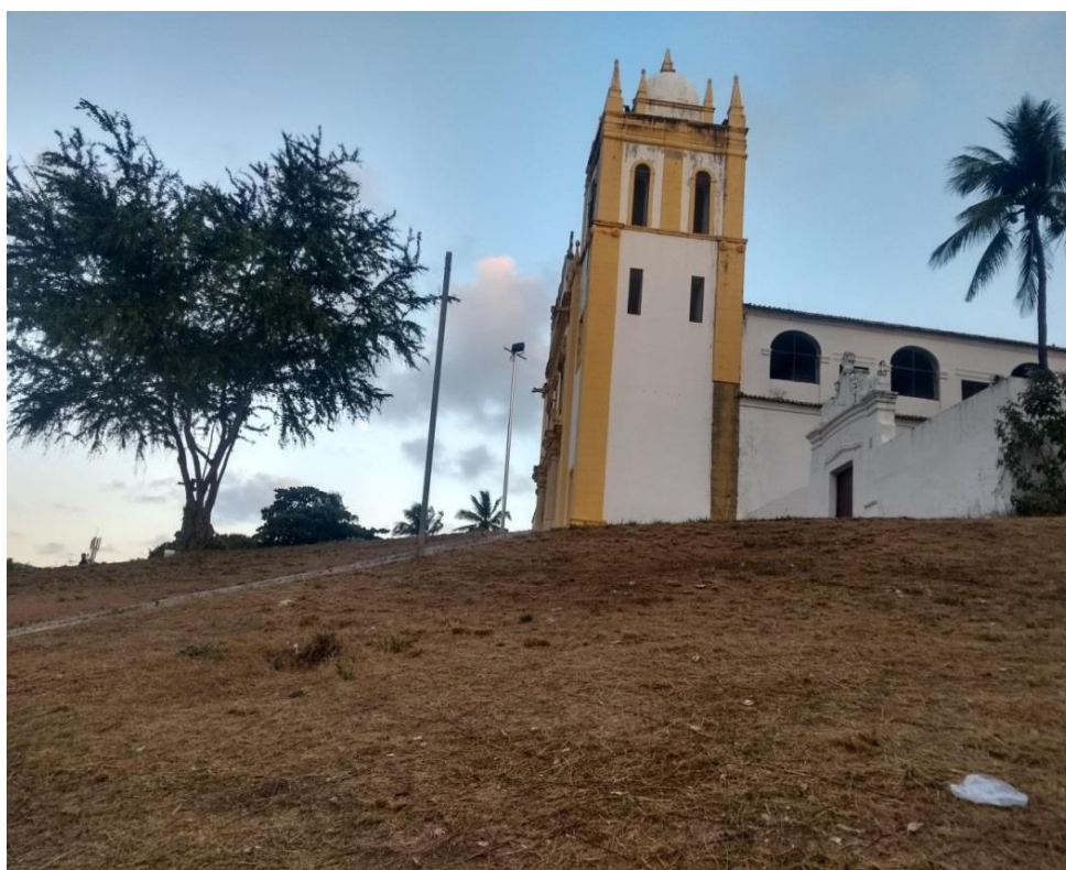
Figura 2 — Lateral oeste do conjunto do convento e da igreja de Nossa senhora do Carmo.
