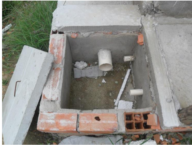
Figura 22: Caixa de passagem da cozinha.
