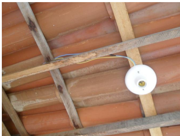
Figura 18: Espaçamento entre caibros e ripas.
