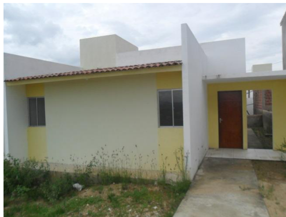
Figura 20: Esquadrias da fachada.
