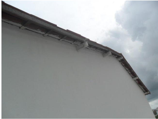
Figura 15: Terças apoiadas na alvenaria.
