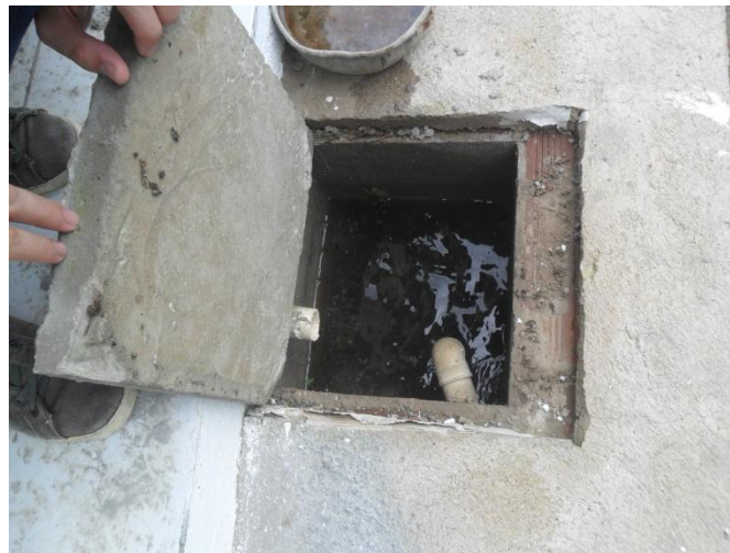
Figura 14: Caixa de passagem da cozinha.
