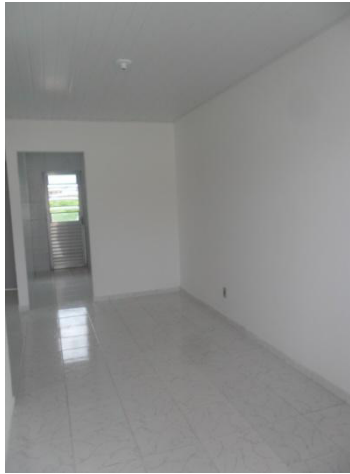
Figura 8: Cerâmica do revestimento do piso.
